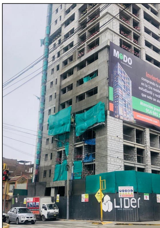
Figura 46: Tarrajeo del sector 4. Fuente: Elaboración propia
