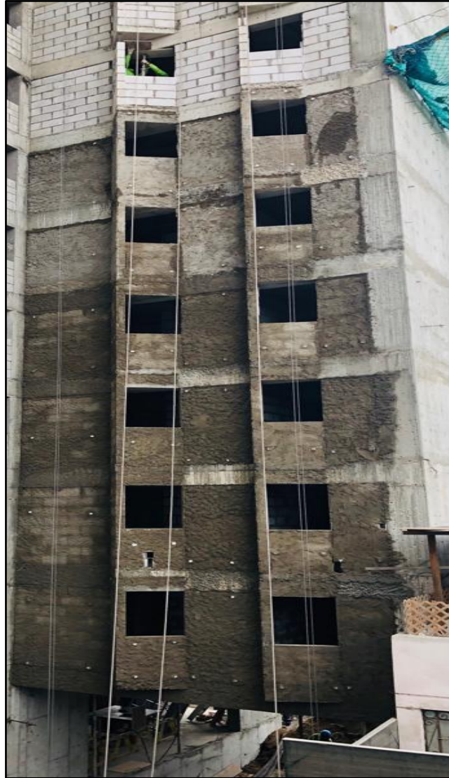
Figura 44: Pañeteo final de los pisos 2° al 7° del sector 1. Fuente: Elaboración propia
