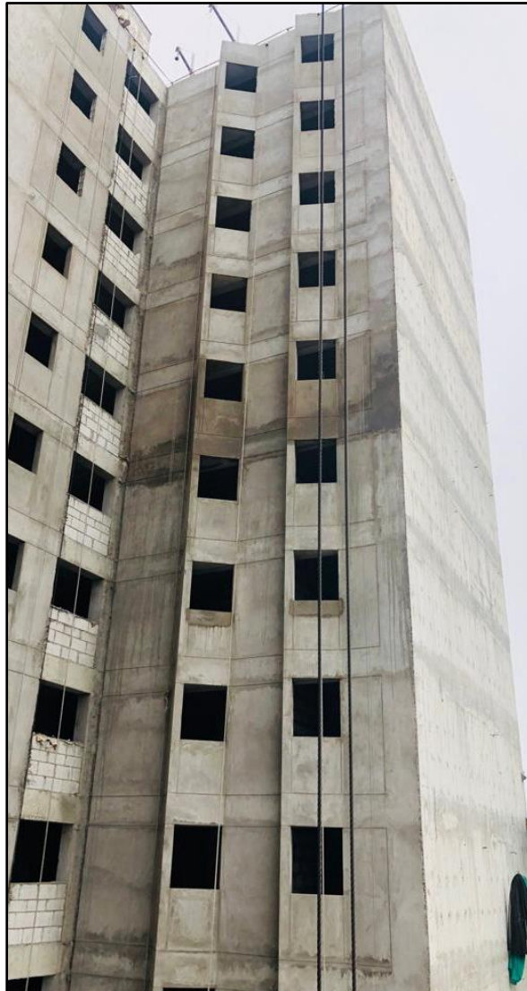
Figura 47: Finalización de bruñas. Fuente: Elaboración propia
