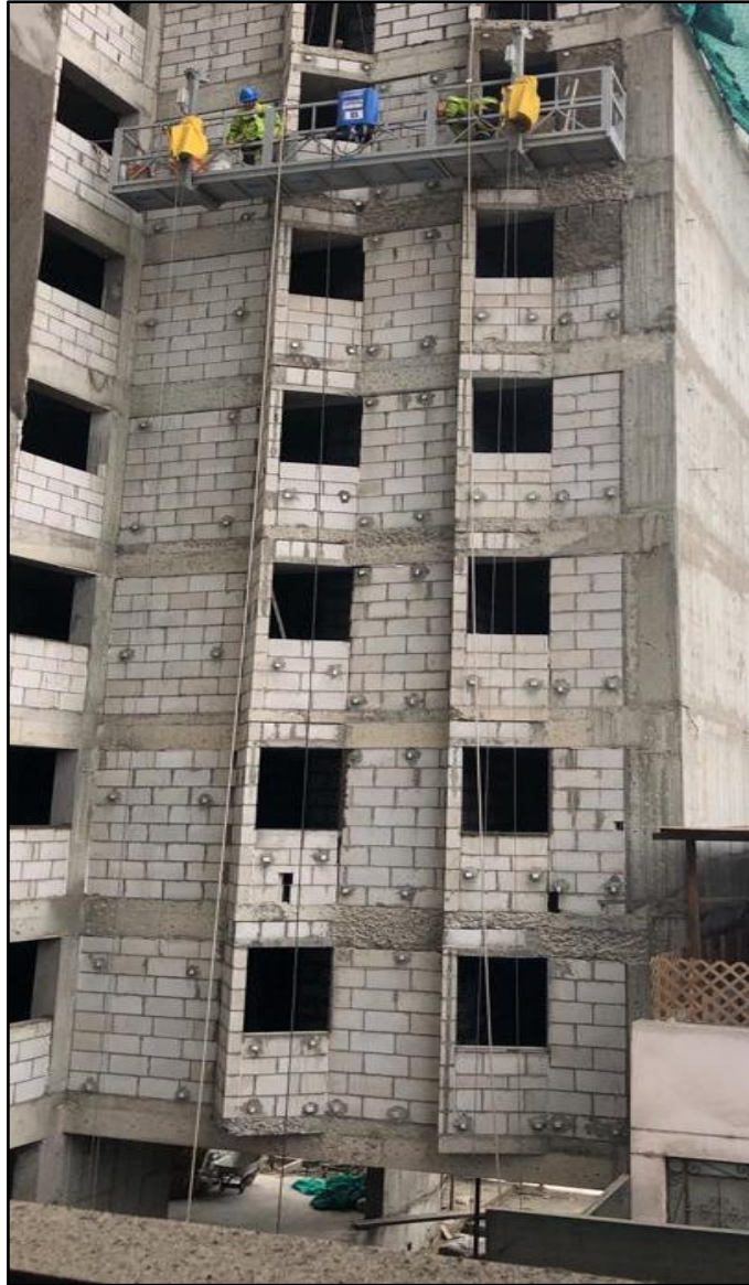
Figura 43: Descalificado final de elementos estructurales de los pisos 2° al 7° del sector 1. Fuente: Elaboración propia
