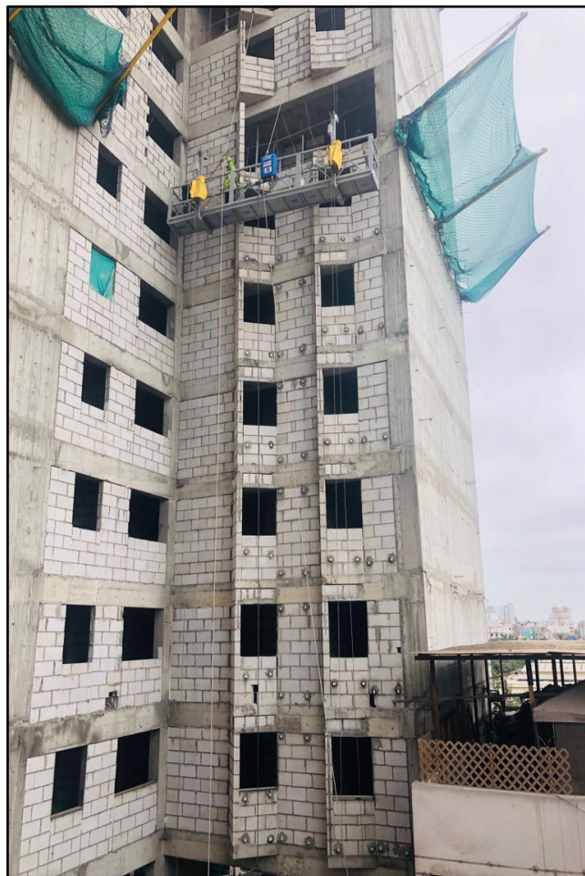
Figura 42: Colocación de puntos del sector 1 desde el piso 2° al 7°.
