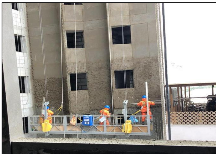
Figura 45: Tarrajeo del sector 1. Fuente: Elaboración propia
