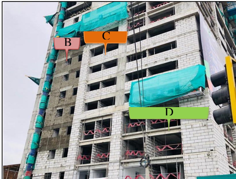
Figura 49: División de andamios del sector 4.
