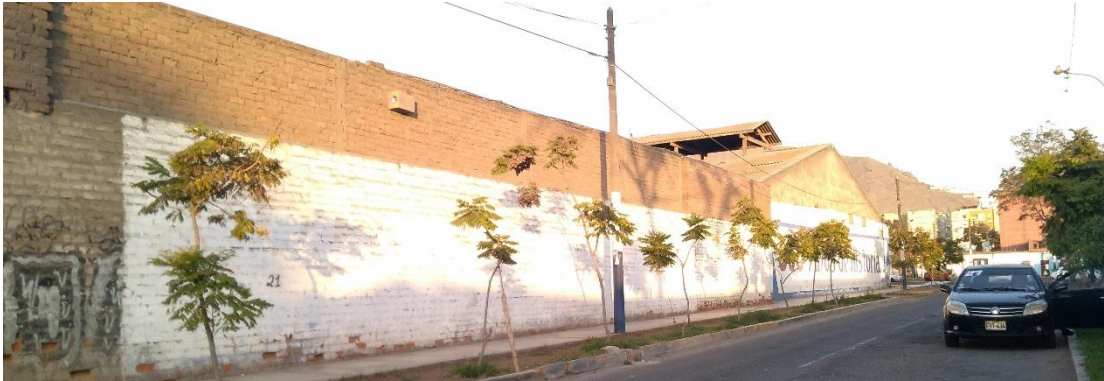
Figura 16. Fotografía actual del Terreno. Fuente: Imagen Propia
