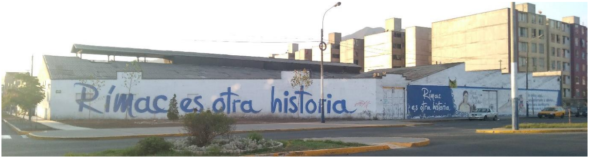
Figura 15. Fotografía actual del Terreno. Fuente: Imagen propia.
