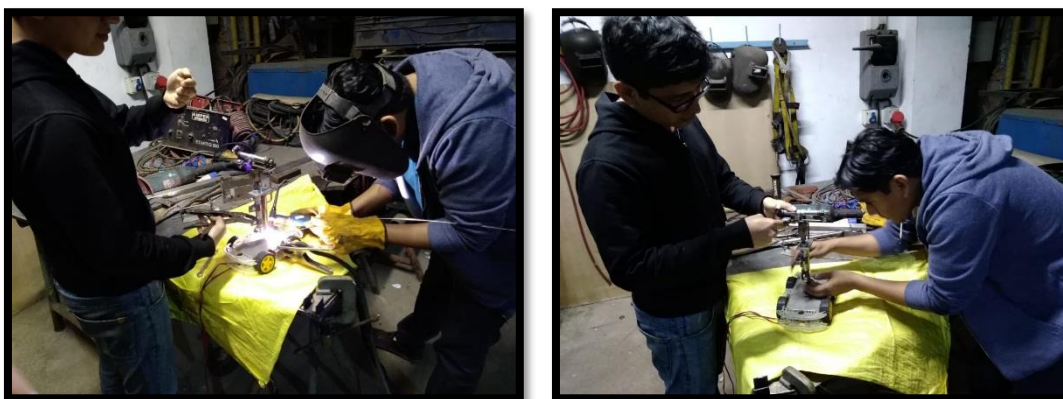
Figura 78. Soldadura de la cartela y ensamblaje de los cilindros neumáticos
