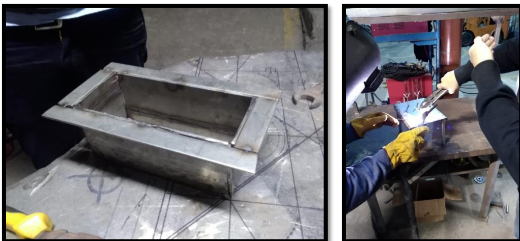
Figura 76. Soldadura de módulo de base fija y bandeja de recubrimiento
