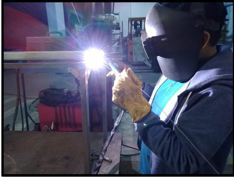
Figura 75. Soldadura del carril de transporte con proceso TIG
