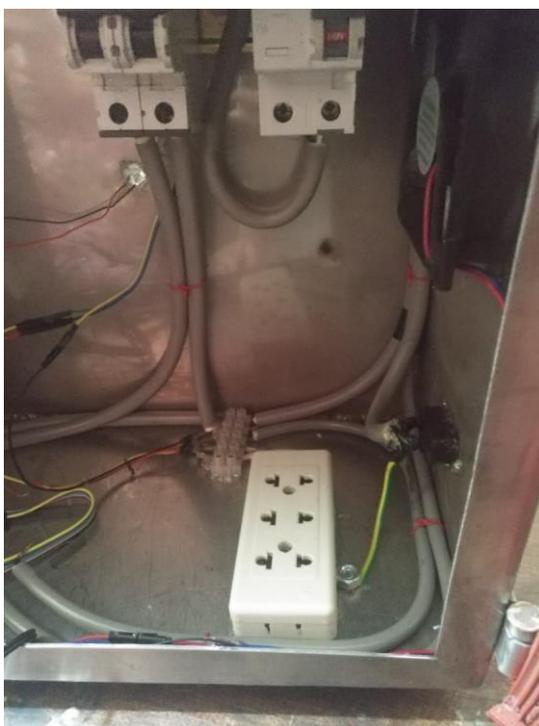
Figura N° 89: Interruptor termomagnético C6 5SY62
