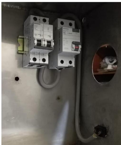
Figura N° 88: Implementación del interruptor termomagnético y diferencial
