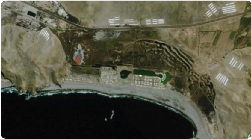
Vista N° 08: Vista aérea del Condominio y entorno Lagunas de Puerto Viejo
