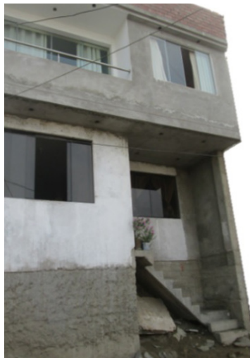
Foto 3: Detalle del muro de contención de concreto
