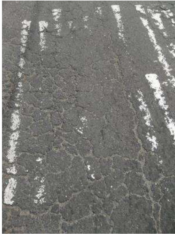
Foto 102 – Falla N°26 - Falla Parcheo, Nivel de severidad leve (11L)
