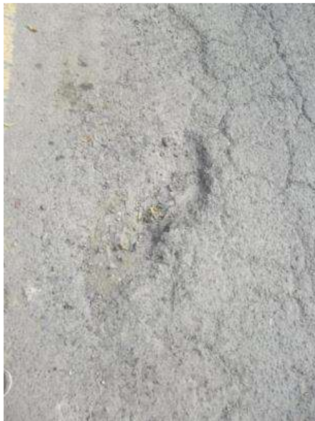
Foto 94 – Falla N°17 - Falla Huecos, Nivel de severidad leve (13L)
