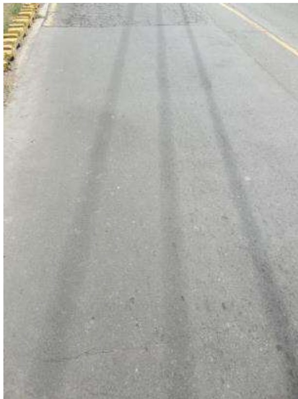
Foto 102 – Falla N°26 - Falla Parcheo, Nivel de severidad leve (11L)
