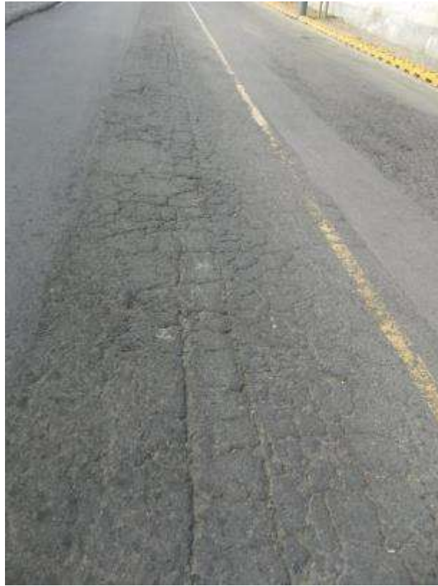
Foto 94 – Falla N°17 - Falla Huecos, Nivel de severidad leve (13L)
