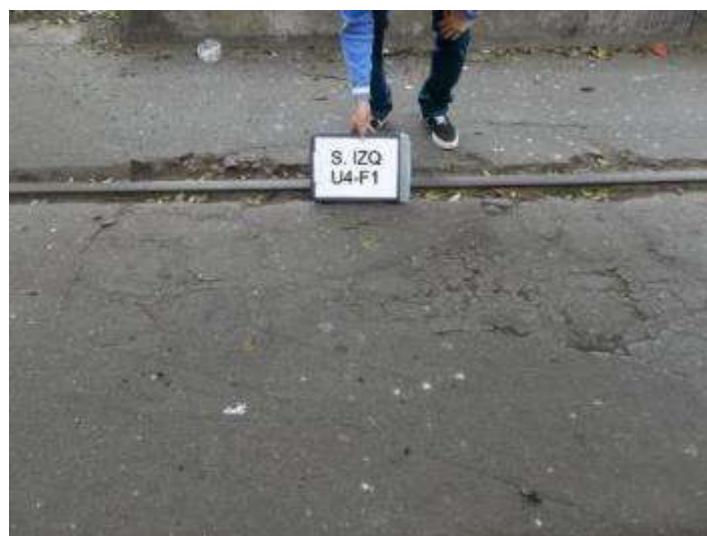
Foto 12 – Falla Nº 1 – Falla Piel de Cocodrilo, Cruce de Vía Férrea y agrietamiento
