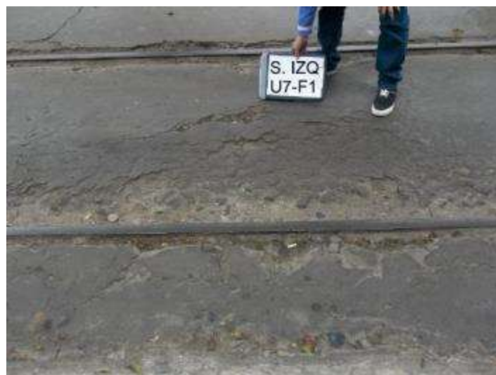
Foto 24 – Falla Nº 1 – Falla de Cruce de vía Férrea, Piel de Cocodrilo, Hueco
