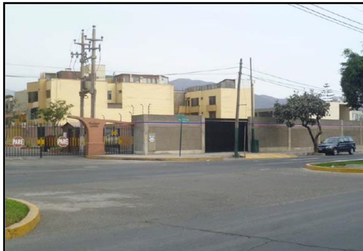
Ilustración 19: Fotografía del terreno, ubicado en la Av. Manuel Olgúin con la calle Santa Isabelita.
