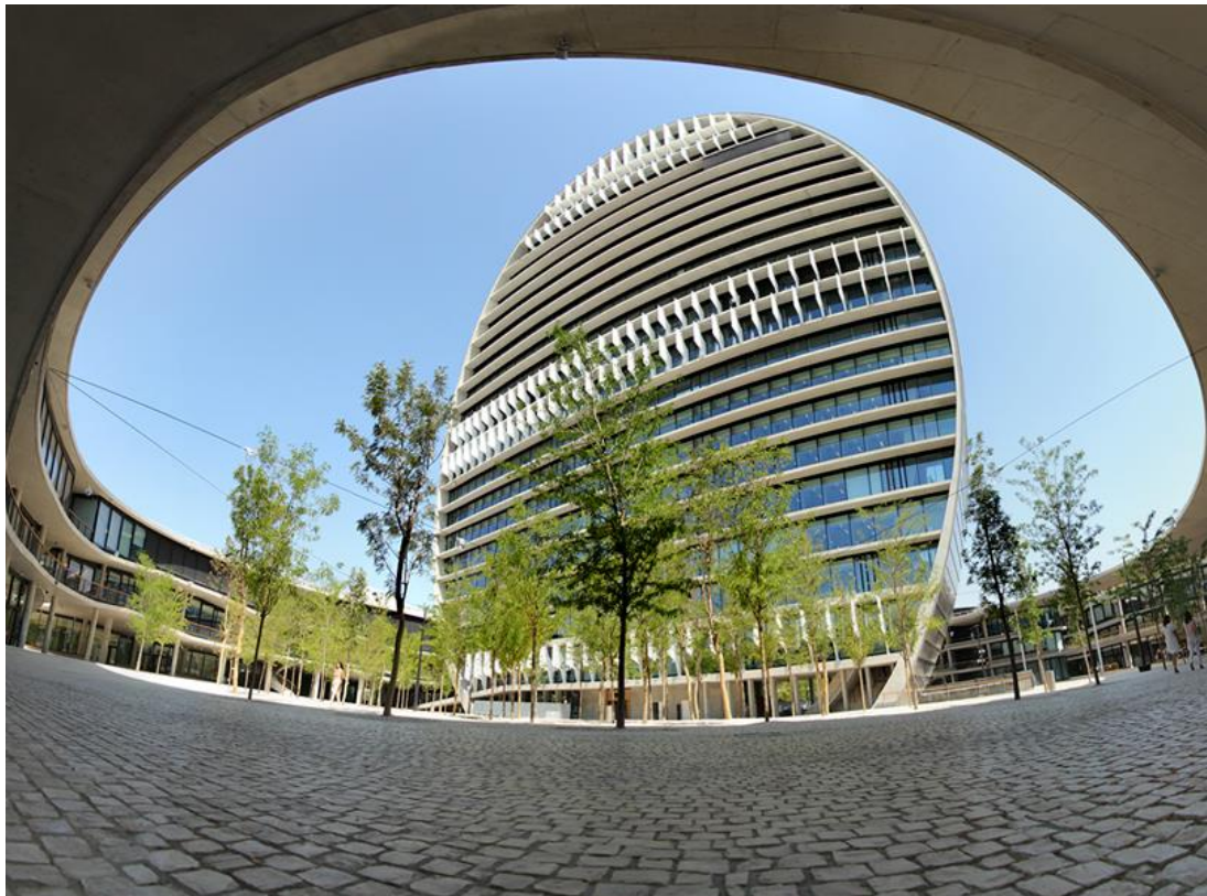
Ilustración 1: Vista Exterior del EDIFICIO DEL BBVA.
