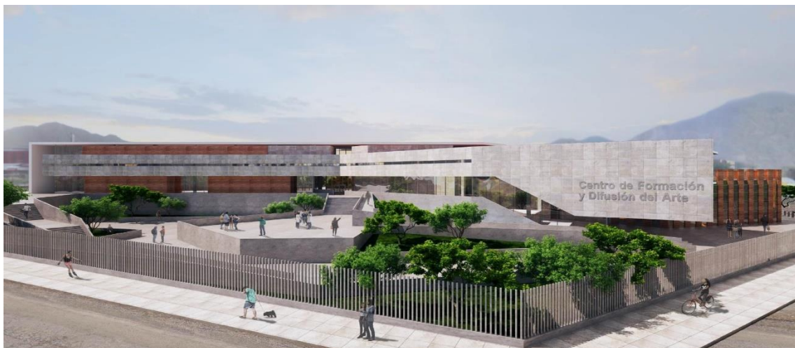
Vista exterior tomada desde la avenida Elmer Faucett
