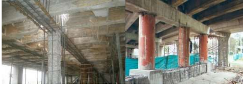
Figura N° 2: Encamisado de columnas en concreto y acero
