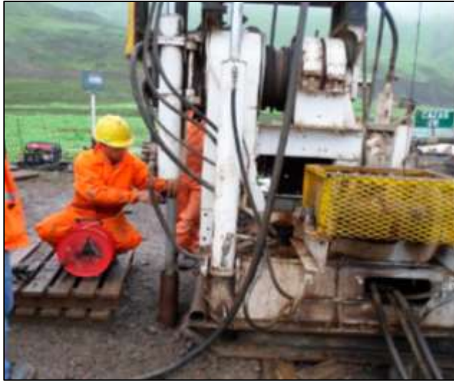
Foto N° 2.4.4: Verificación de profundidad de perforación. Fuente: Geo Master - Informe de Limpieza y Drenaje de Piezómetros para Estudio Hidrogeológico de la U.E.A. Cristina, 2014.
