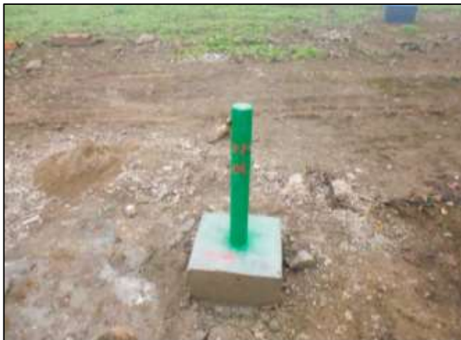
Foto N° 2.4.6: Piezómetro instalado. Fuente: Geo Master - Informe de Limpieza y Drenaje de Piezómetros para Estudio Hidrogeológico de la U.E.A. Cristina, 2014.
