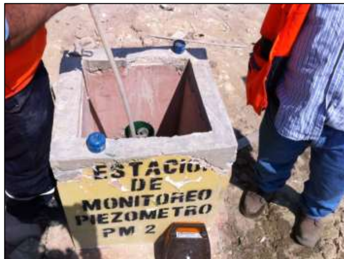
Foto N°4.5.1: Verificación de los piezómetros.
