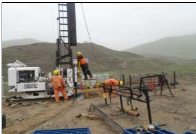
Foto N° 2.4.1: Trabajos de perforación.
