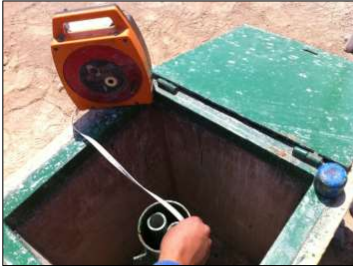
Foto N° 4.5.4: Medición del nivel detectado por el limnómetro eléctrico.
