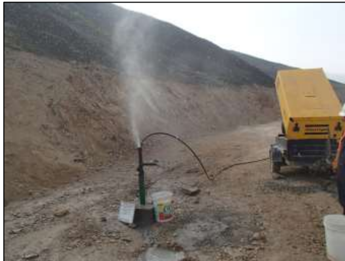
Foto N° 2.5.1: Expulsión de agua con aire durante 10 minutos. Fuente: Geo – Master - Informe de Limpieza y Drenaje de Piezómetros para Estudio Hidrogeológico de la U.E.A. Atocongo, 2015.
