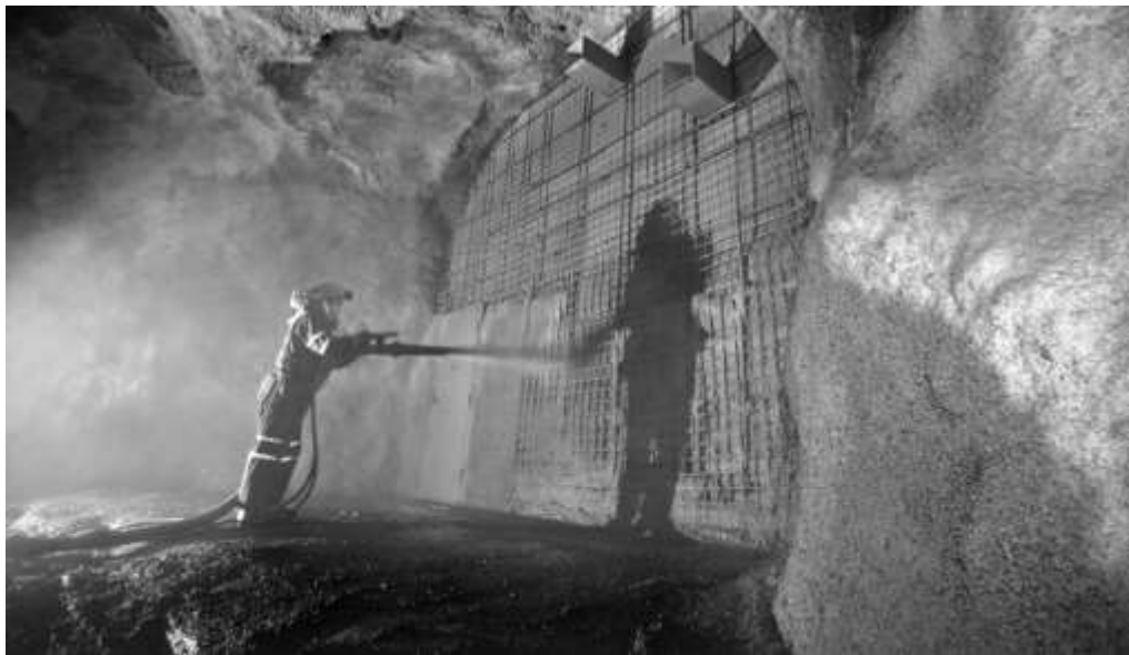
Figura 2 Concreto proyectado o shotcreteFuente:
