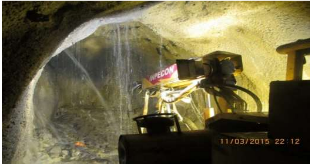
Figura 3 Colocación vía húmeda en condiciones adversas
