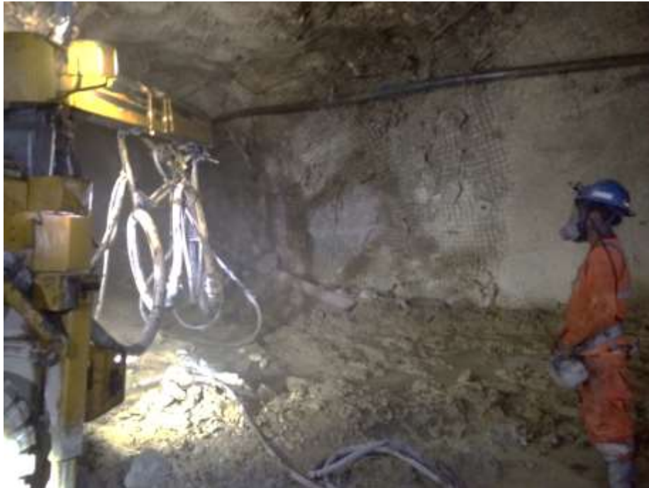
Figura 6 Manipulación automatizada del Robot en colocación de Shotcrete,
