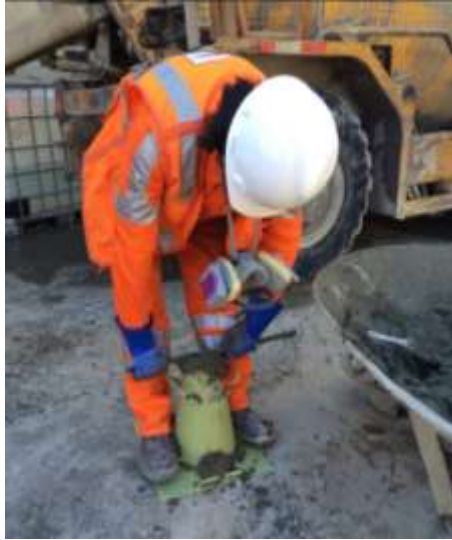
Figura 34 Medición del Slump
