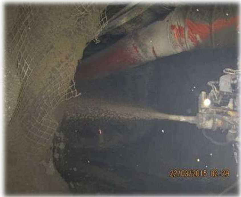
Figura 4 Colocación vía húmeda
