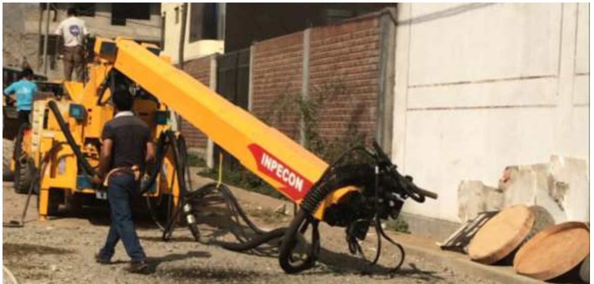
Figura 39 Proceso de toma de muestra robotizado.
