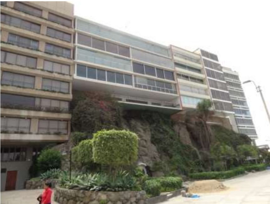
Imagen N° 12 Fotografía de Campo.
