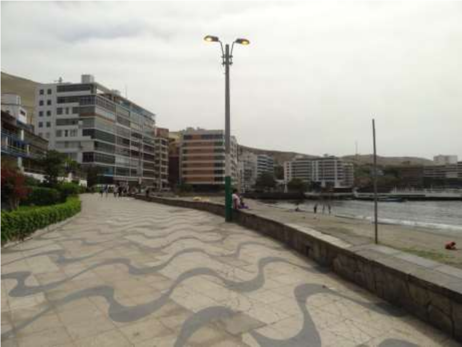
Imagen N° 10 Fotografía de Campo.
