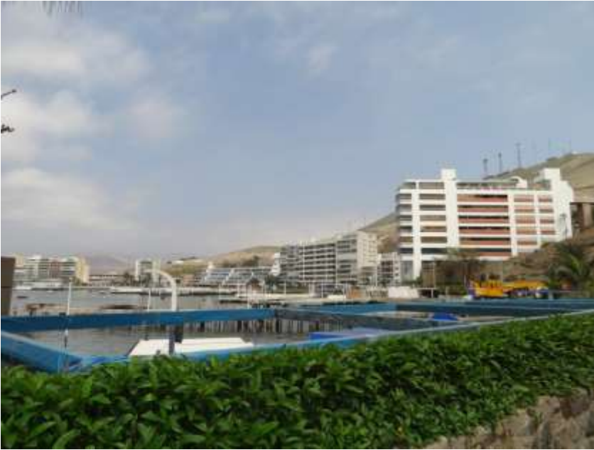
Imagen N° 11 Fotografía de Campo.
