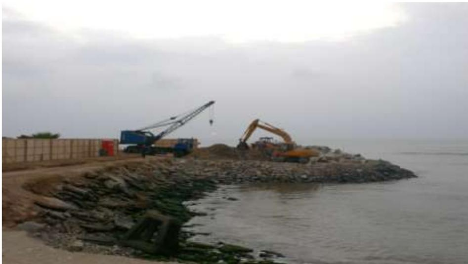
*Ilustración 13: Inicio de Construcción de Espigones*
