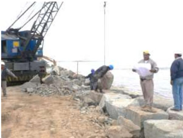
*Ilustración 16: Supervisión de Topografía para talud de Roca*
