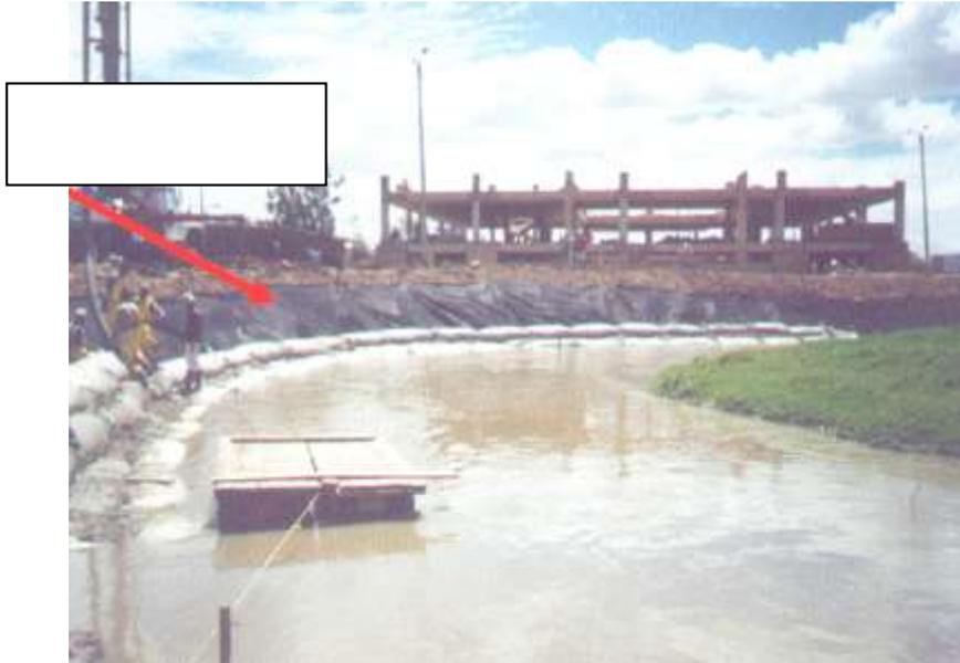
*Ilustración 18: Geotextil No Tejido NW030M*
