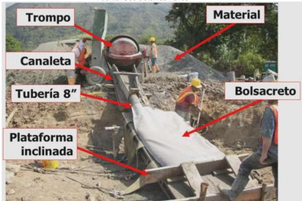
Ilustración 23: Armado de canaletas para llenado por caída libre
