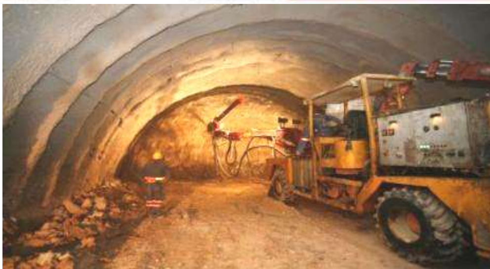
Foto N°3: Proyecto de los Túneles de Puruchuco y Accesos, que consiste en la construcción de dos túneles viales paralelos.
