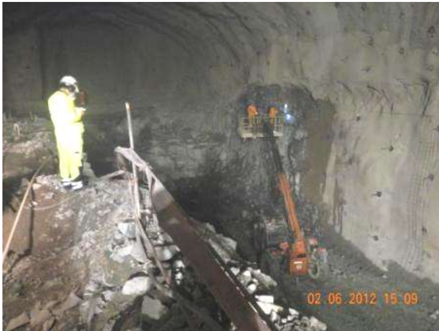
Foto N°1: Proyecto Hidroeléctrico Cheves, ubicado en la provincia de Oyón del departamento de lima, a unos 2200msnm.
