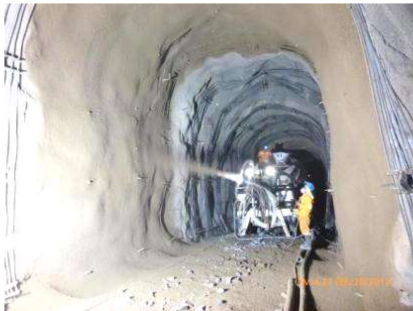
Foto N°9: Túnel de Conducción – Proyecto Cheves
