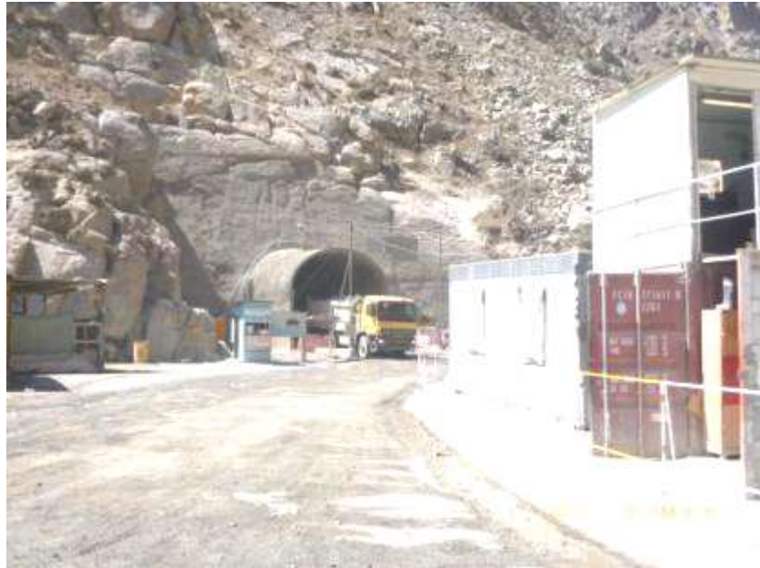
Foto N°7: Entrada del Túnel de Transferencia – Proyecto Cheves
