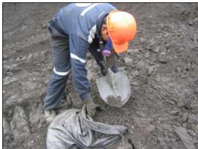
**Figura 50.** Toma de muestras representativas del material de relave drenado que es utilizado para la conformación del dique
