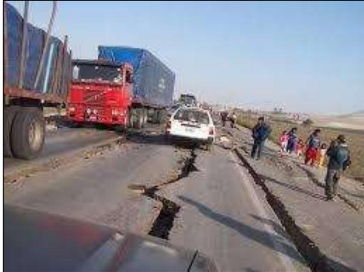
**Figura 19.** Detalles de subsidencia de la panamericana sur durante el sismo de Ica en el 2007.
