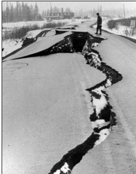
**Figura 03.** Efecto de la licuación es el desplazamiento lateral de un suelo con arena y arcilla. Las casas se deslizaron una distancia aproximada de 150m y el nivel del terreno bajo a 11m en la localidad de Tumagain Heihts en Anchorage.
