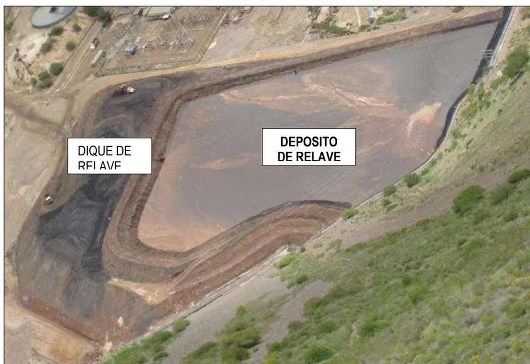
**Figura 32.** Vista panorámica de la Zona Norte, se aprecia la presa de relaves con sus ampliaciones, el dique de refuerzo y el relleno que influyen en el talud natural hacia el Rio Mantaro
