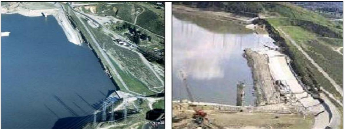
**Figura 04.** Presa baja de San Fernando antes y después del colapso por el terremoto de 1971
