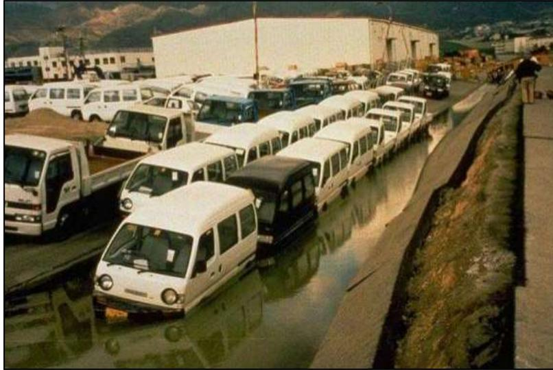
**Figura 07.** Desplazamiento lateral debido a licuación de suelos, ocasionó el hundimiento de 1.2- 2.00 metros de la superficie del pavimento y flujo local. Sismo del kobe 1995.
