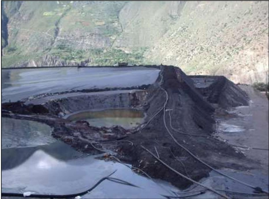
**Figura 41.** Dique intermedio que se viene construyendo para la ampliación de la presa de relaves.
