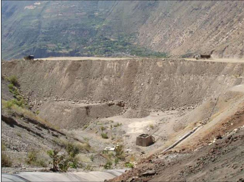
**Figura 43.** Zona del botadero que ha permitido conformar un terraplén de 24m de altura apoyando en el dique de refuerzo a la presa norte.
