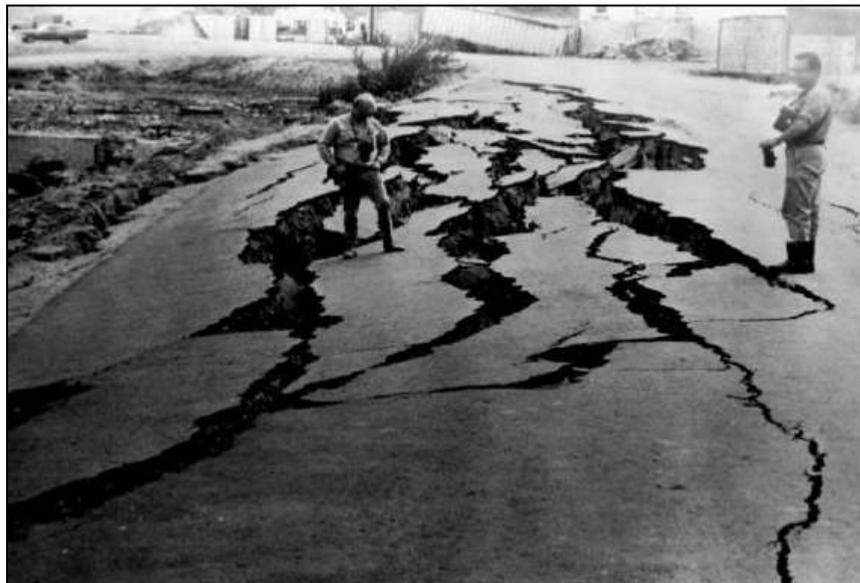
**Figura 16.** Asentamiento y fisuramiento de carreteras asfaltadas en el oeste de Chimbote debido a licuación y desplazamiento lateral de depósitos lagunares y de playa. Sismo del 31 de mayo de 1970
