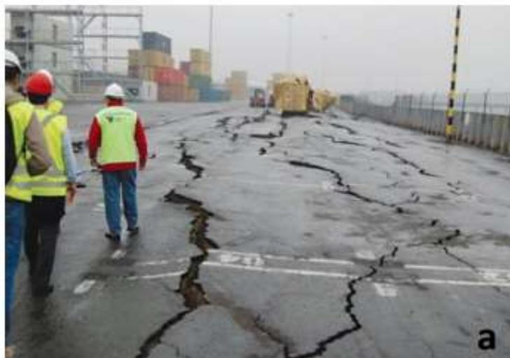
**Figura 14.** Falla del terreno del borde costero producto de la licuación del terreno en el borde costero
