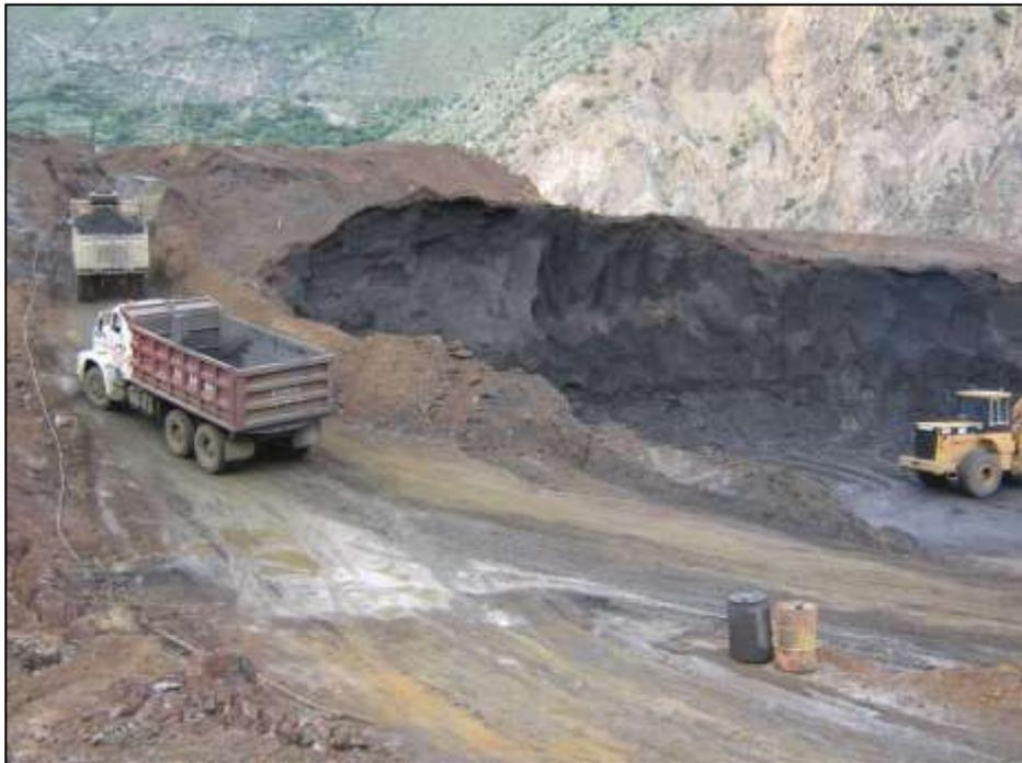
**Figura 47.** Zona del relave drenado en la zona del espesador que es llevado para la conformación del dique en la presa norte.
