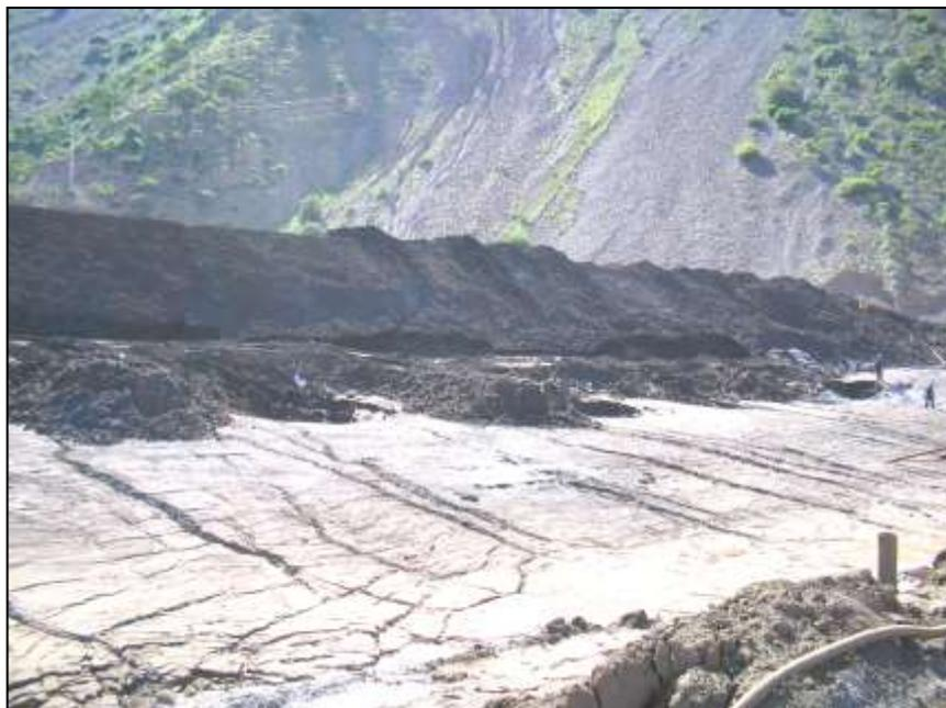
**Figura 37.** Vista Frontal de dique que se viene conformando a 40m del dique de inicial de relaves
