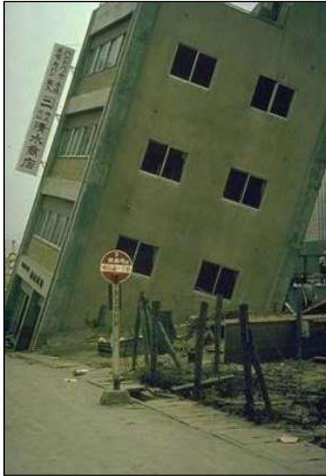
**Figura 01.** Asentamiento e inclinación de edificio ocasionado por licuación de suelos. Sismo de Niigata, Japón. 16 de junio de 1964.
