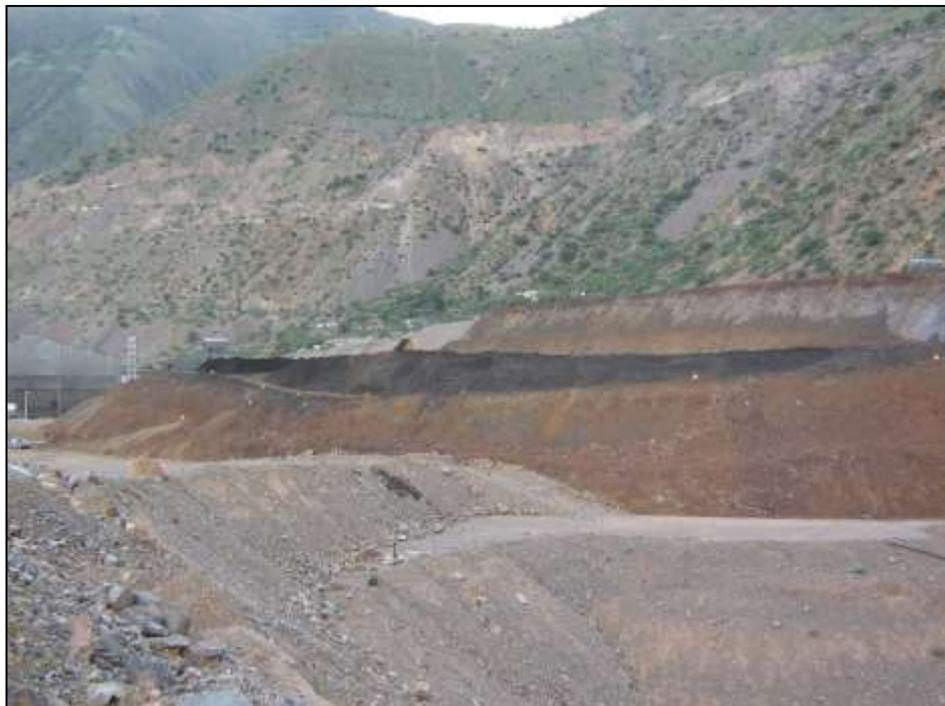
**Figura 46.** Vista del dique de relave en la parte frontal que se viene elevando hasta homogenizar con el dique interior.
