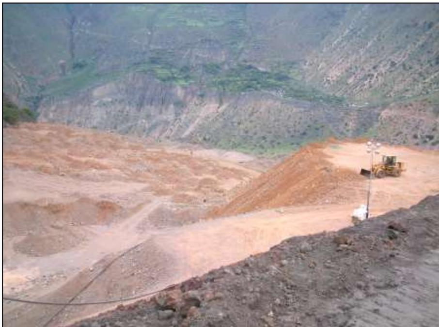
**Figura 42.** Zona del botadero que se viene conformando un terraplén de soporte al dique de la presa.
