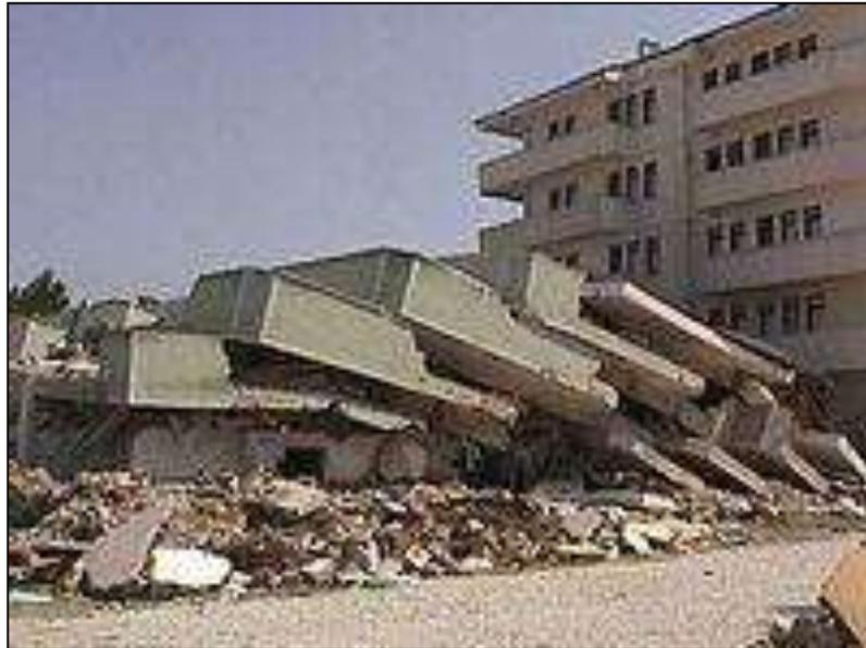
**Figura 10.** Edificación que se volcó debido a la licuación que indujo pérdida de la capacidad portante debajo de la cimentación tipo losa.
