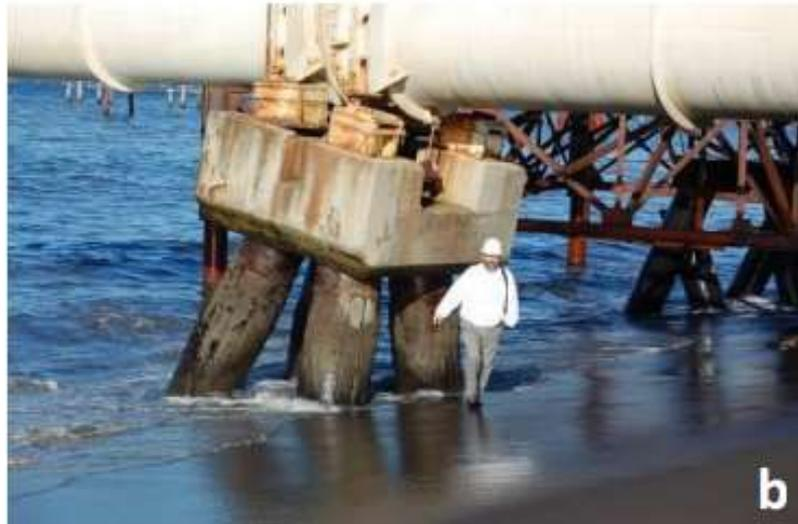
**Figura 15.** Falla de los pilotes producto de la licuación del terreno en el borde cortero
