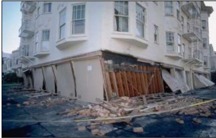
**Figura 06.** Asentamiento por punzonamiento limitado por licuación debido a encontrarse en un suelo de relleno con arena y nivel freático alto en el distrito de marina.
