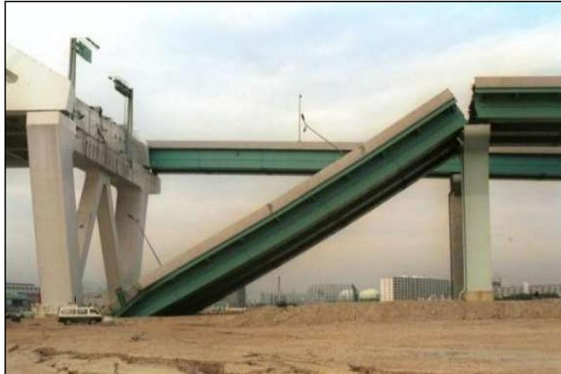
**Figura 09.** Colapso de un tramo del puente nishihomiya, debido al desplazamiento lateral de los muros de apoyo durante el sismo de kobe, 1995
