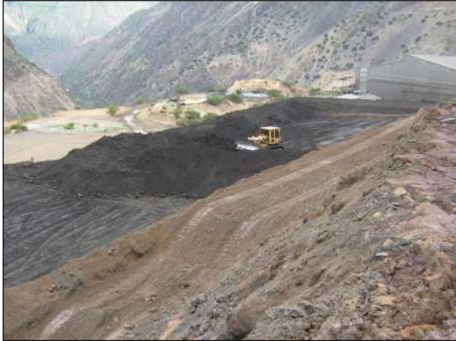
**Figura 45.** Vista del dique de relave frontal que se viene elevando hasta alcanzar al dique intermedio.
