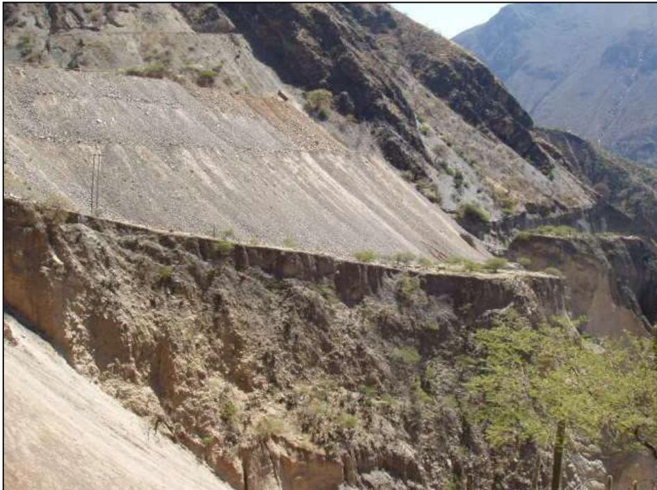
**Figura 44.** Zona del botadero con un relleno de 24m, sobre el terreno natural de la Zona Norte y que influye sobre el talud hacia el río Mantaro.
