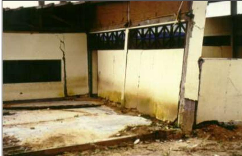
**Figura 18.** Daño a la escuela de TAHUISHCO debido a asentamiento diferencial y agrietamiento del terreno debido a licuación.
