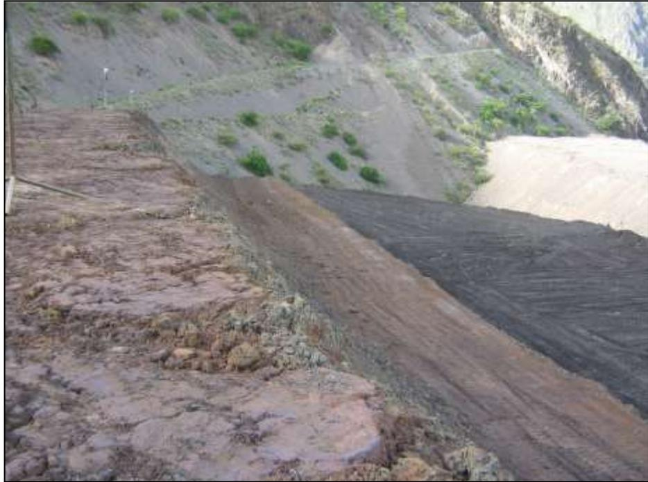
**Figura 48.** Dique de relave que se viene elevando hasta alcanzar al dique intermedio en la presa norte.
