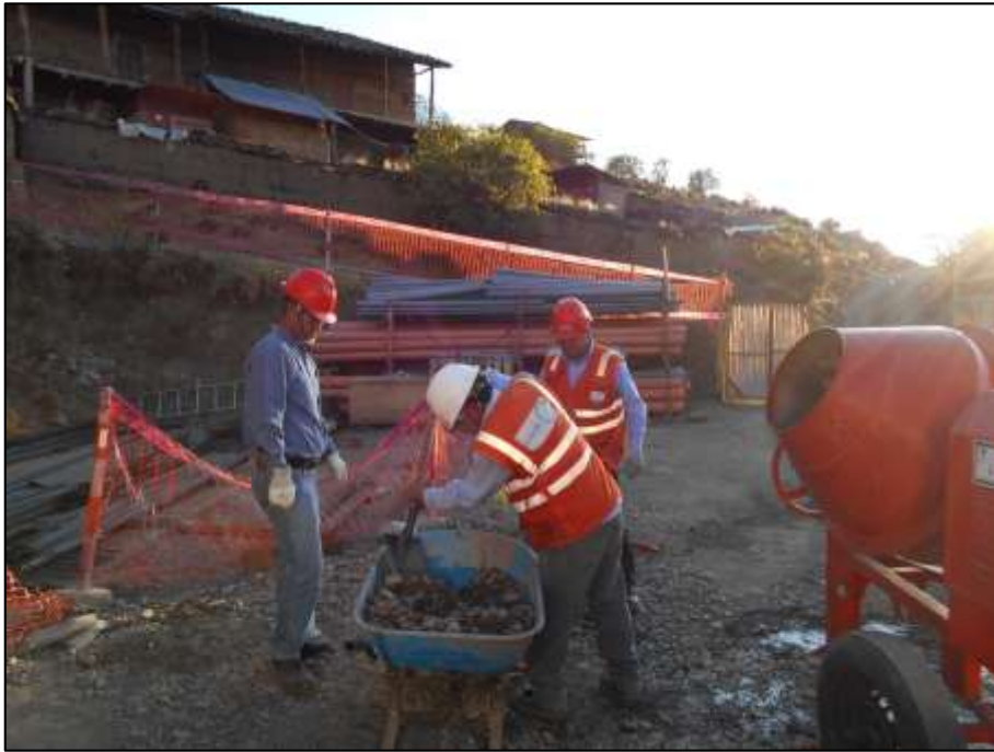
Colocación de los agregados a la mezcladora
