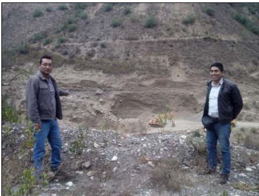
Trabajos de Explotación de la Cantera Huachis
