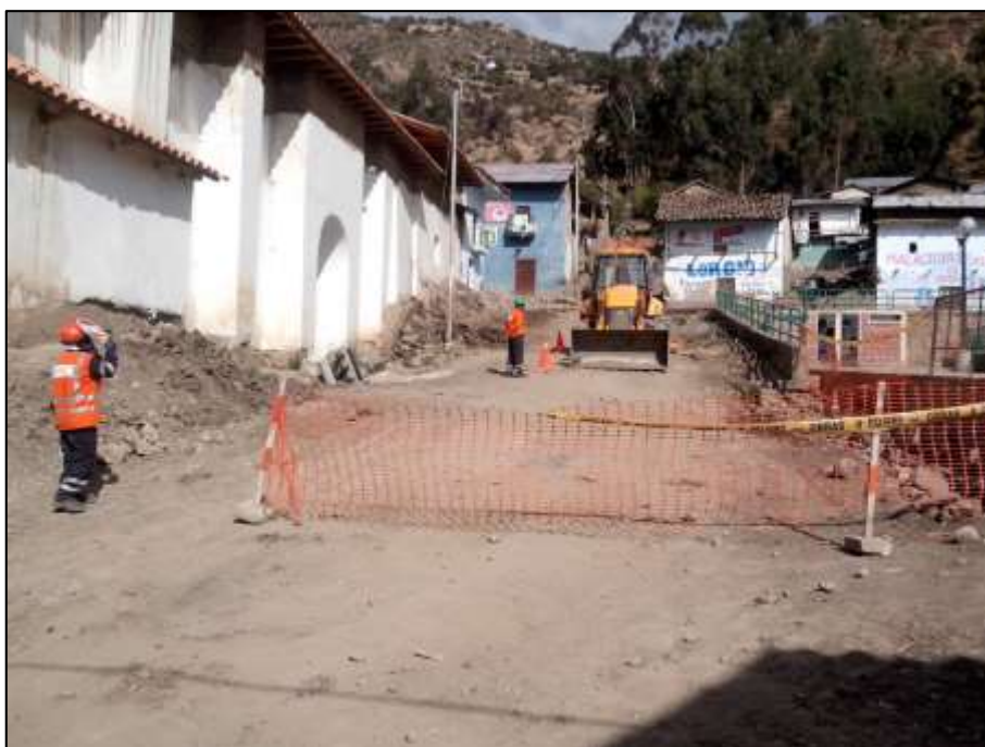
Inicio de los trabajos en las Calles del Centro Poblado
