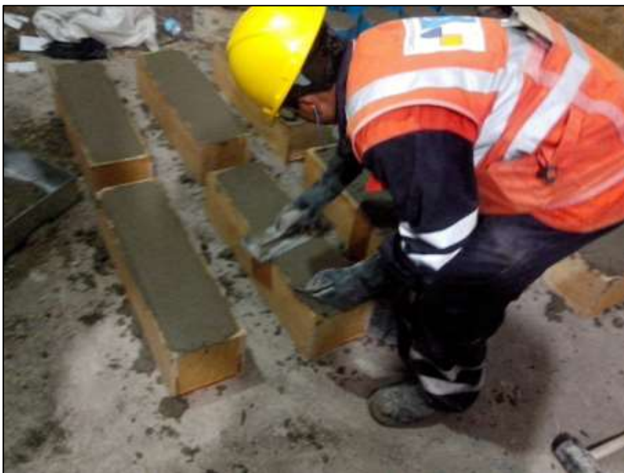
Nivelado de la mezcla al borde del molde
