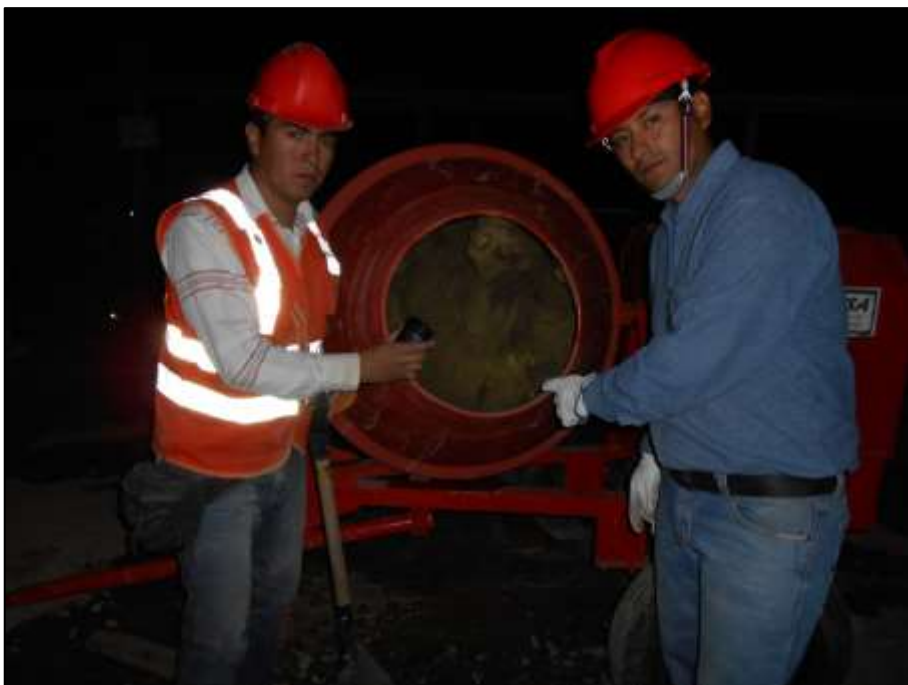
Mezclado del Concreto
