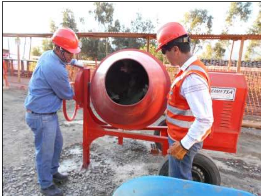
Figura 24: Mezclado del concreto
