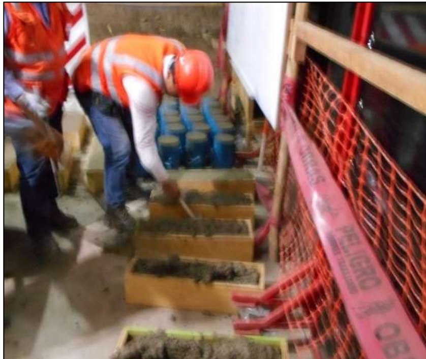
Figura 26: Colocación del concreto en los moldes de vigas
