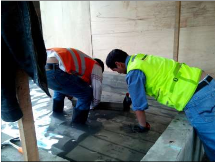
Colocación de las Vigas en la poza de curado
