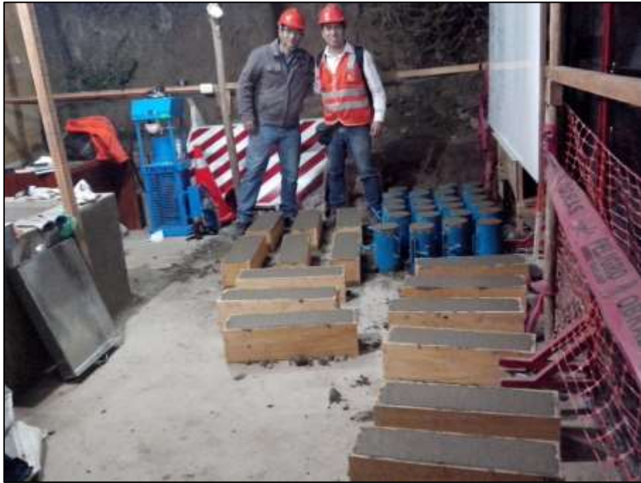
Probetas cilíndricas y Vigas con la mezcla de concreto
