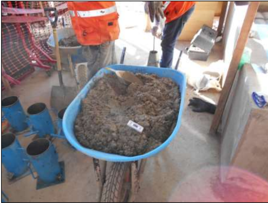
Toma de temperatura a la mezcla de concreto
