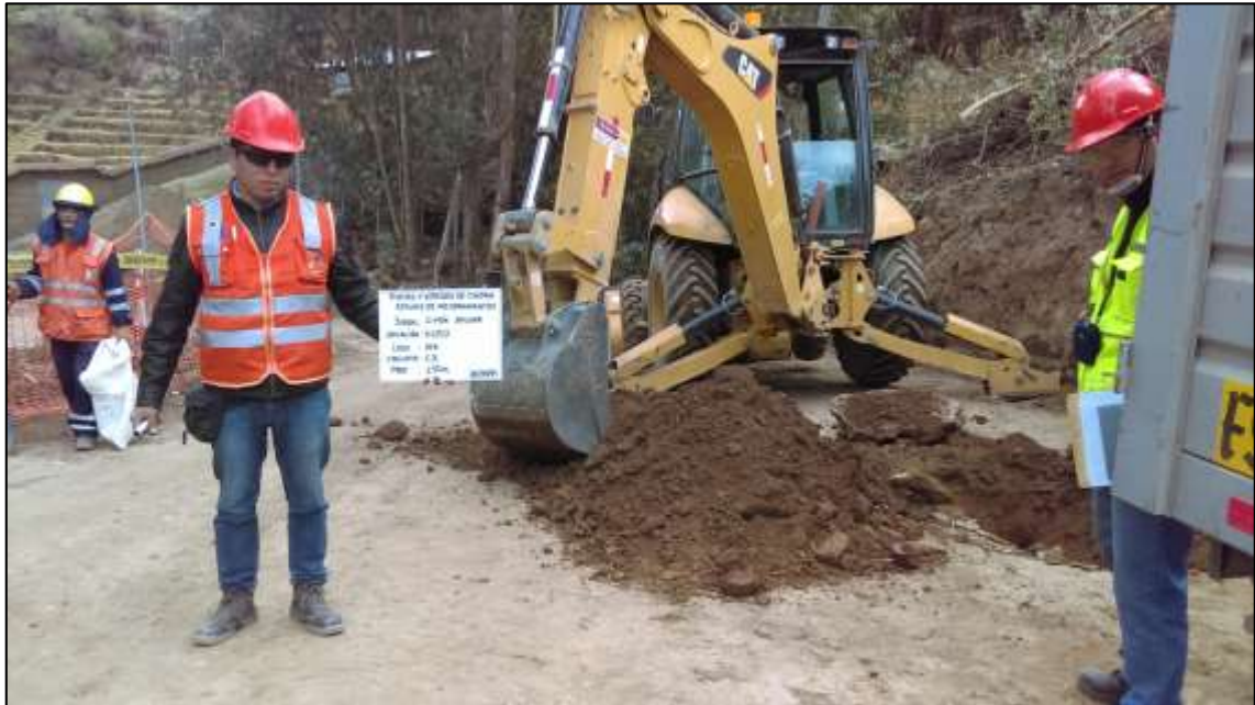
Calicata C-3, Jr. Simón Bolívar
