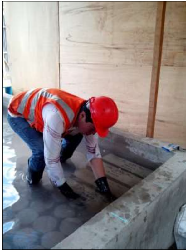
Vigas de concreto dentro de la poza de curado
