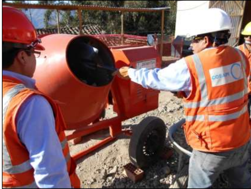
Figura 23: Colocación de los materiales en la Mezcladora
