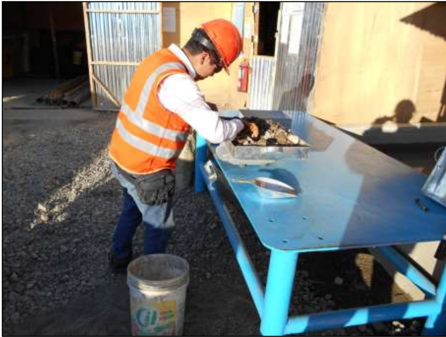
Pesaje del Agregado Grueso
