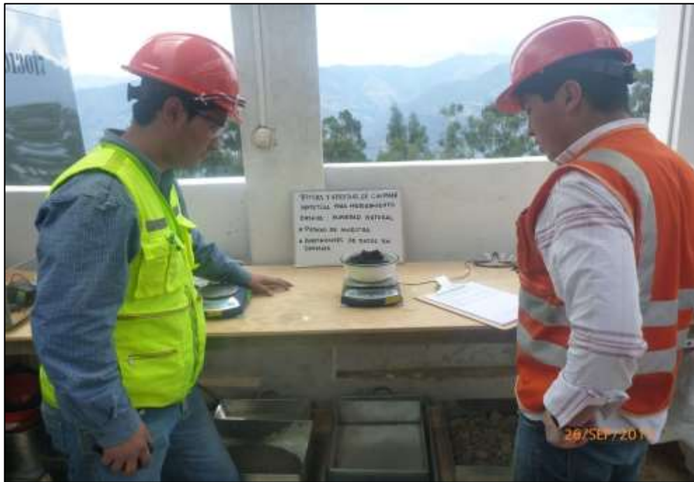
Ensayo de Humedad
