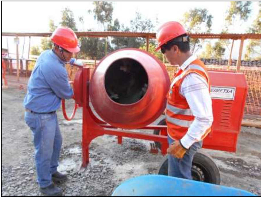
Mezclado del Concreto
