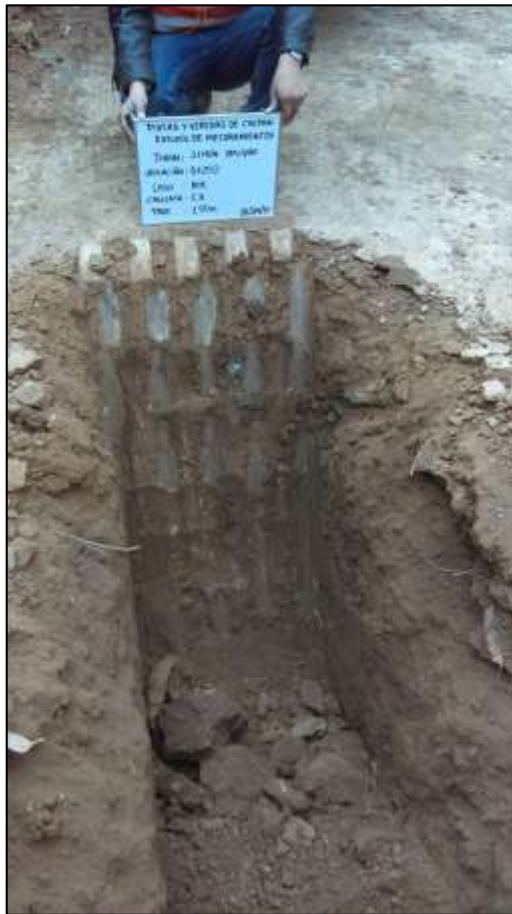
Calicata C-3, Jr. Simón Bolívar
