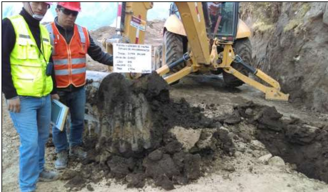
Calicata C-4, Jr. Simón Bolívar
