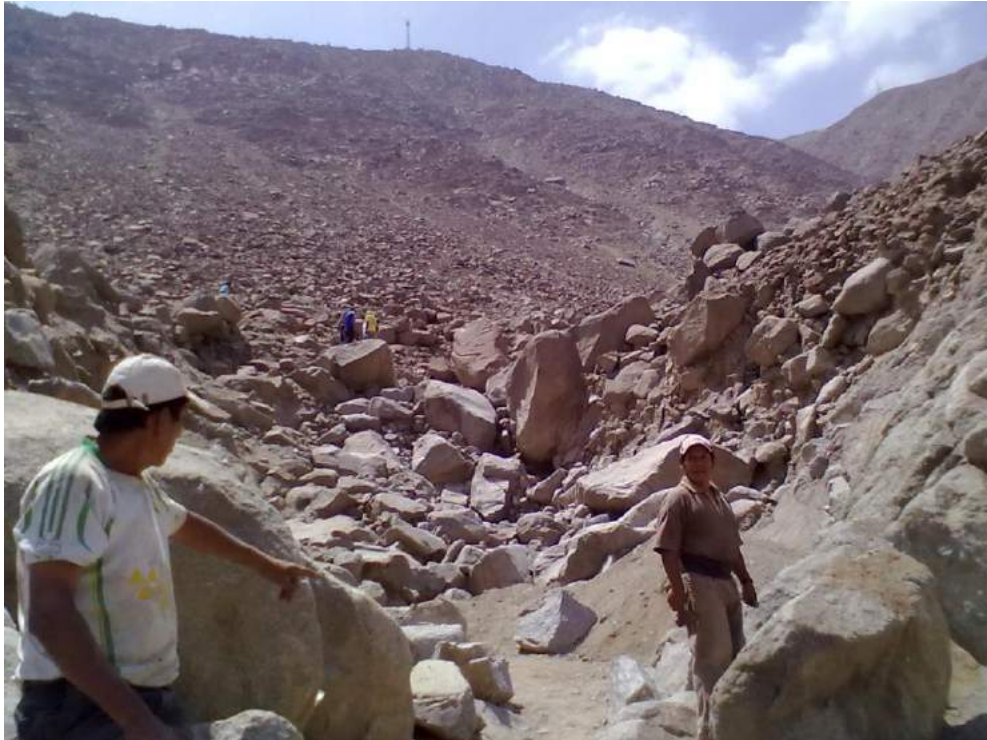
Foto 5. Sección de la parte alta de la quebrada, en pleno trabajo de construcción de muro de contención
