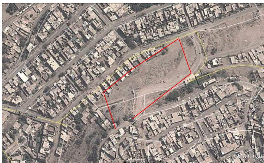
Imagen 14. Zona a construir la defensa contra el deslizamiento de lodo y piedra
