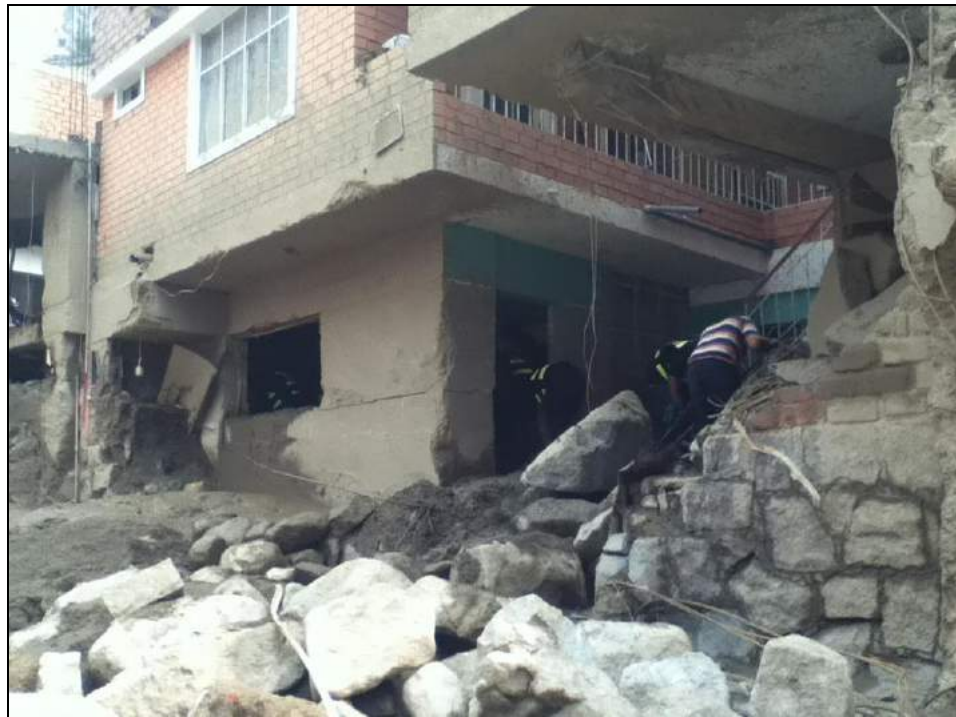
Foto 62. Foto Quebrada Mariscal
