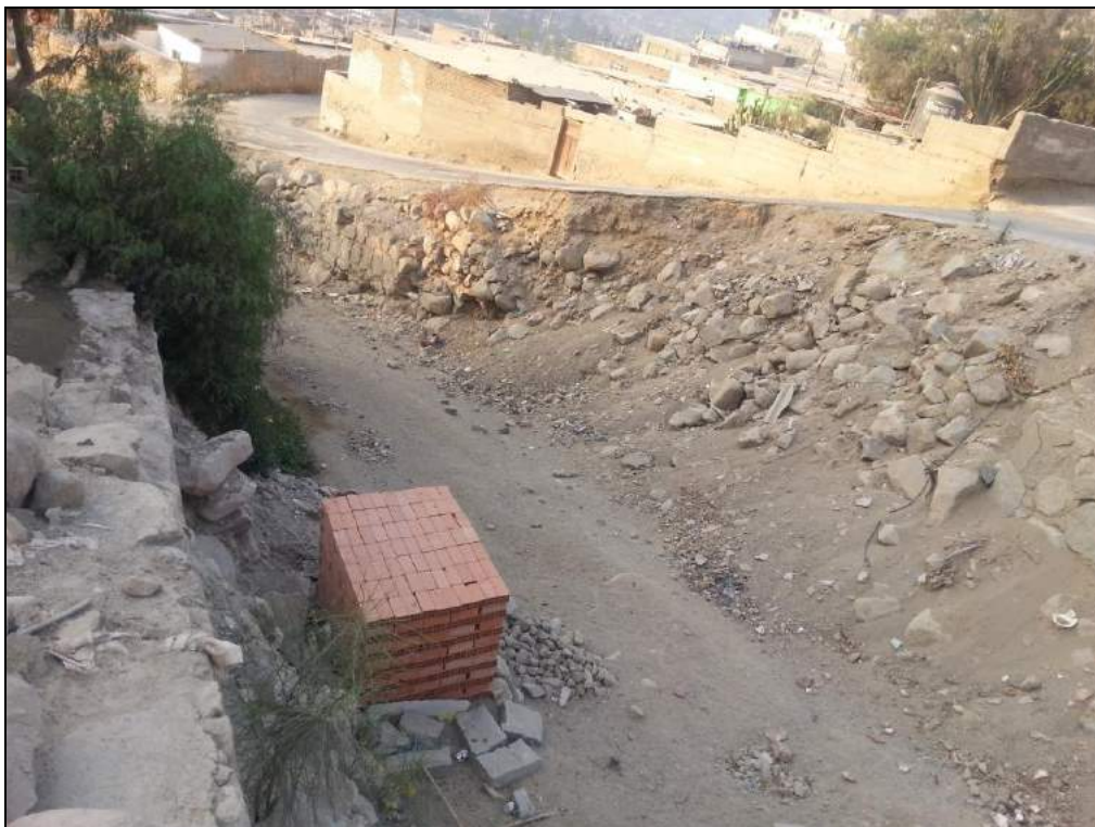
Foto 41. Parte del cauce de la quebrada sin muros de contención
