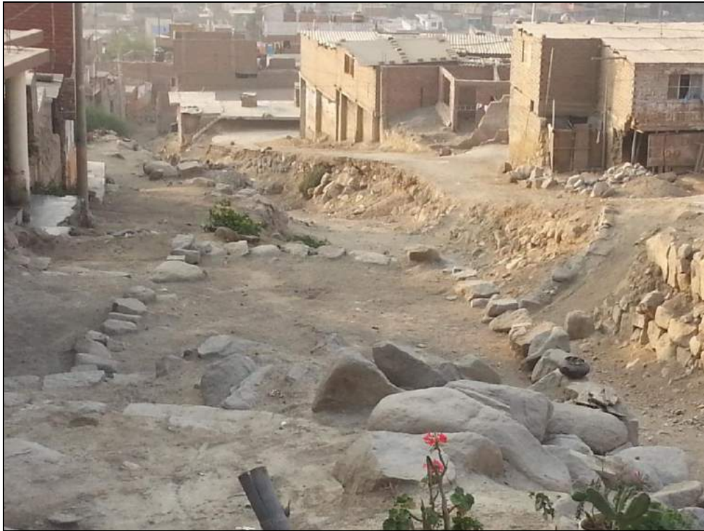
Foto 41. Parte del cauce de la quebrada sin muros de contención
