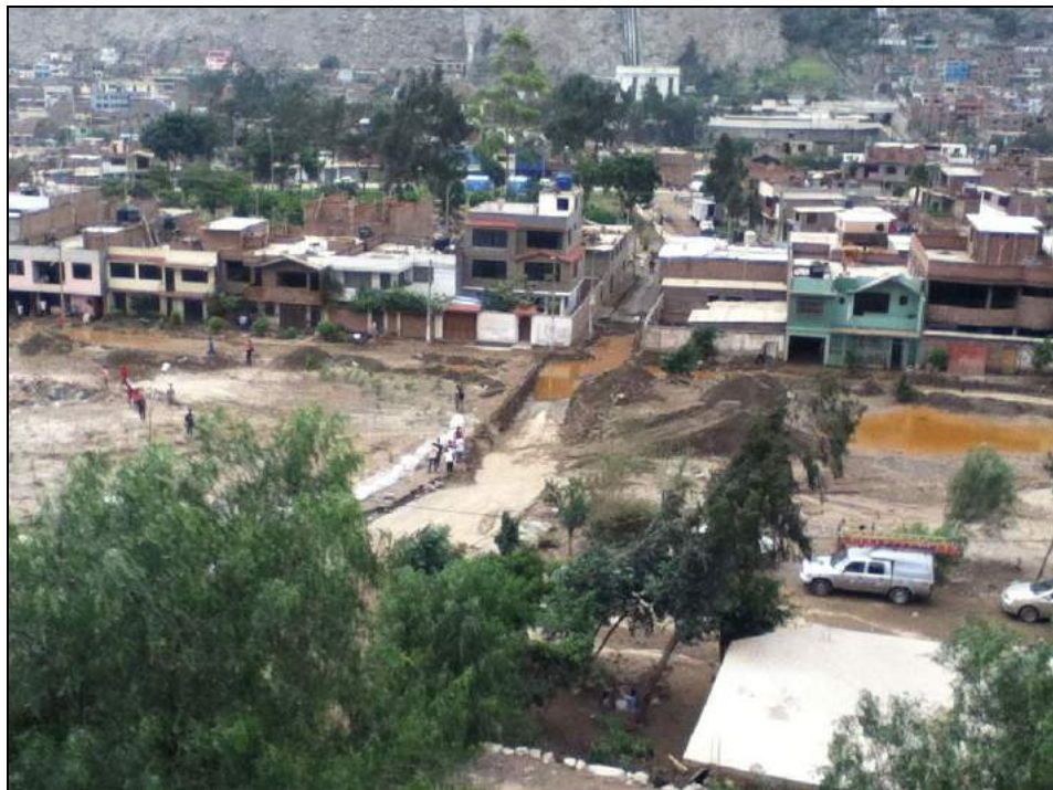
Foto 66. Foto Quebrada Mariscal
