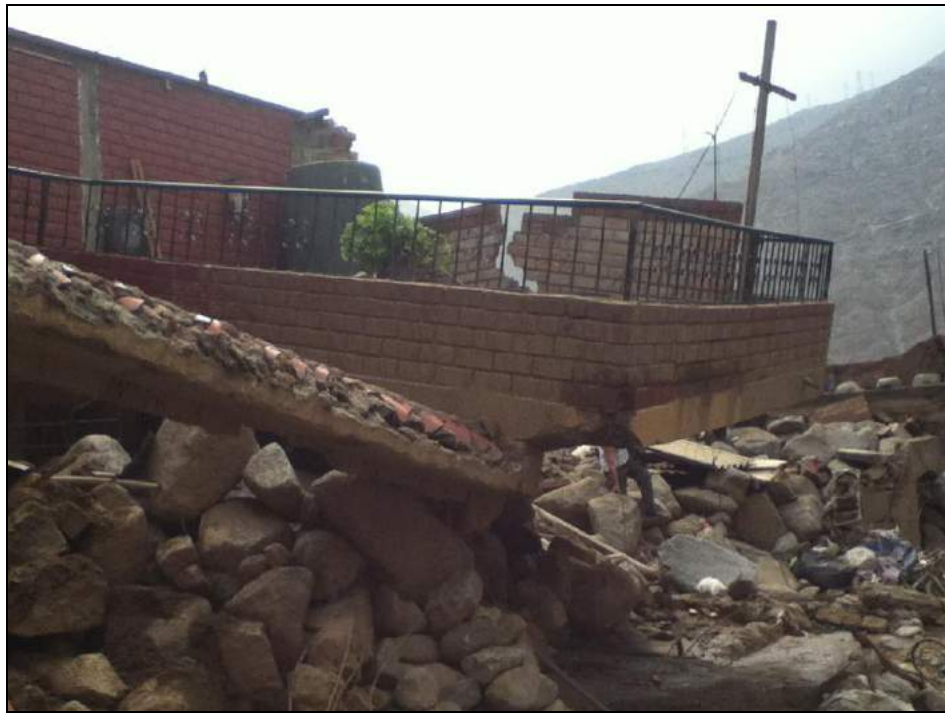
Foto 64. Foto Quebrada Mariscal
