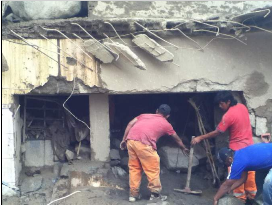
Foto 59. Foto Quebrada Mariscal
