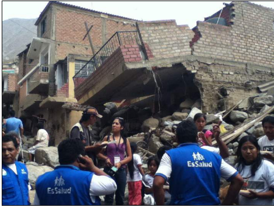
Foto 61. Foto Quebrada Mariscal
