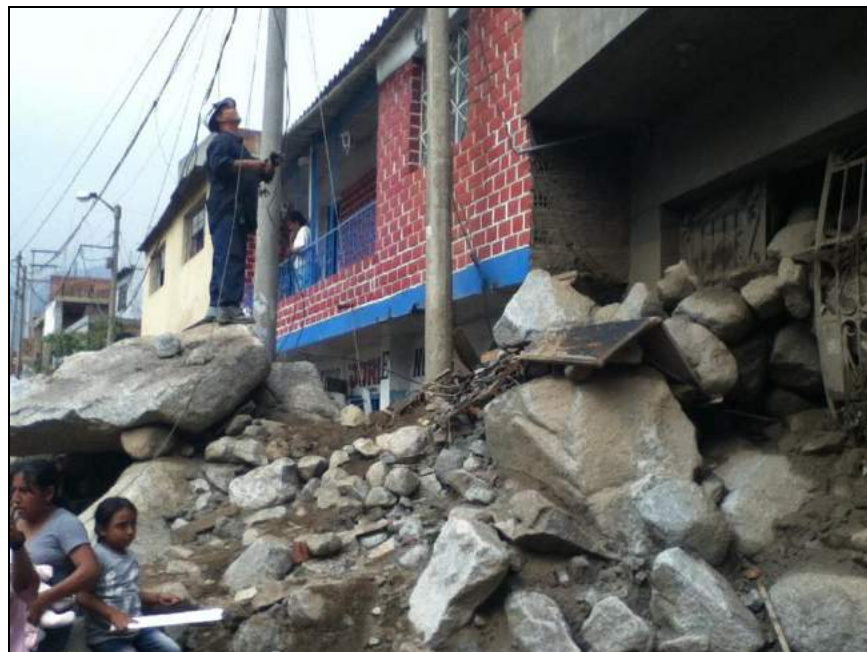
Foto 58. Foto Quebrada Mariscal
