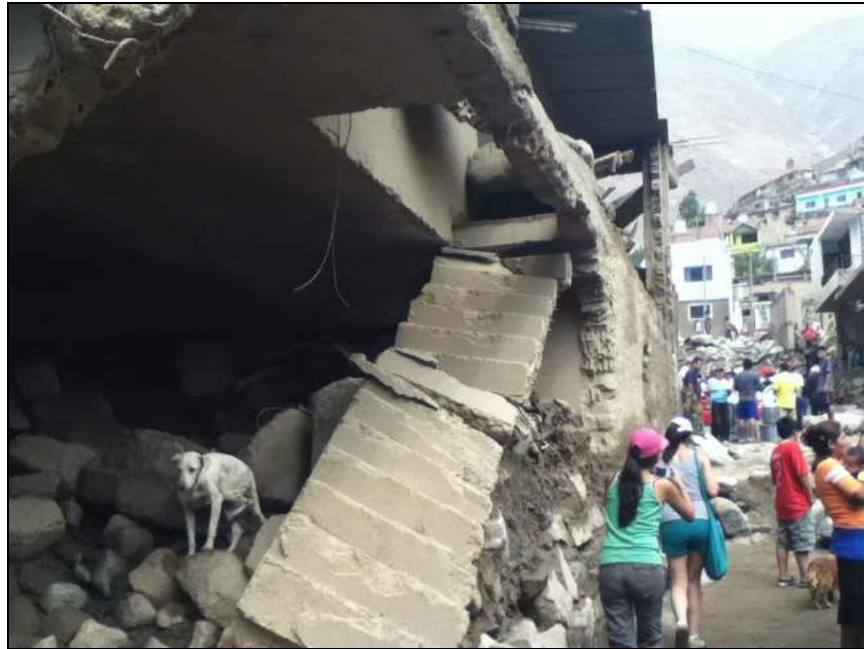
Foto 57. Foto Quebrada Mariscal
