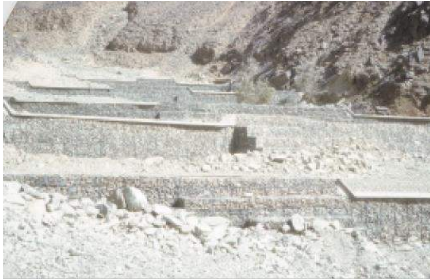
Foto 2. Gaviones colocados por etapas funcionamiento de diques
