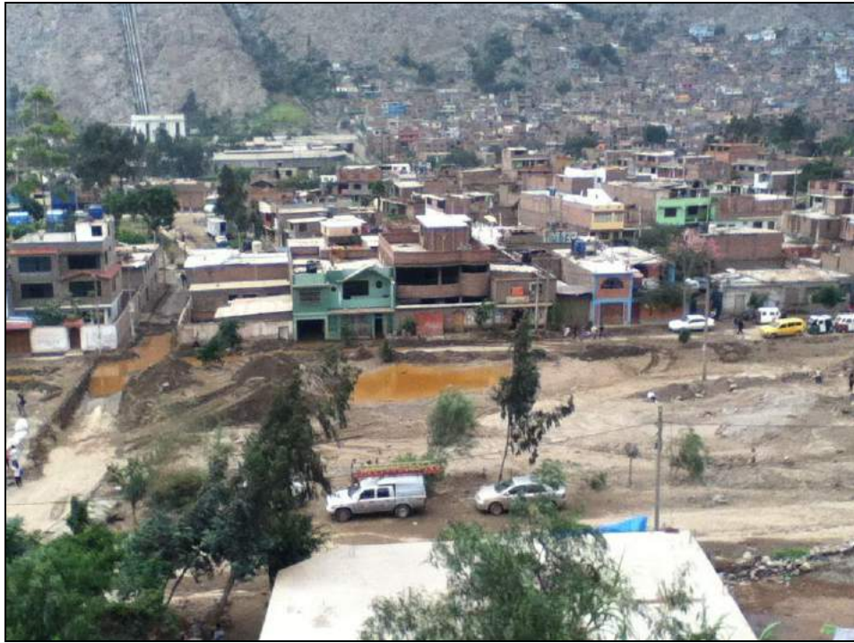
Foto 65. Foto Quebrada Mariscal
