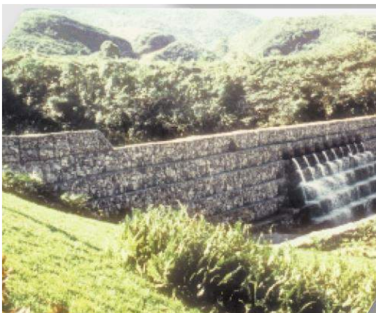
Foto 1. Gaviones usados como diques
