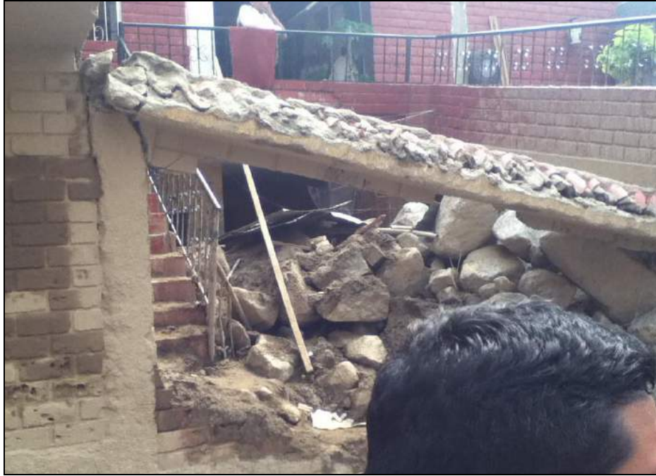
Foto 67. Foto Quebrada Mariscal
