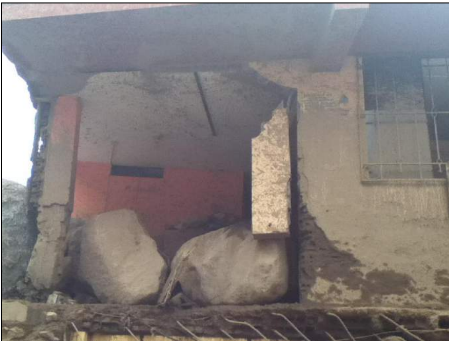
Foto 60. Foto Quebrada Mariscal
