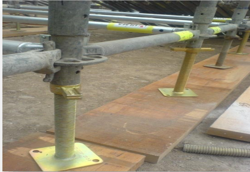
Foto 13: Muestra las gatas bases del alzaprismado sobre tablones.
