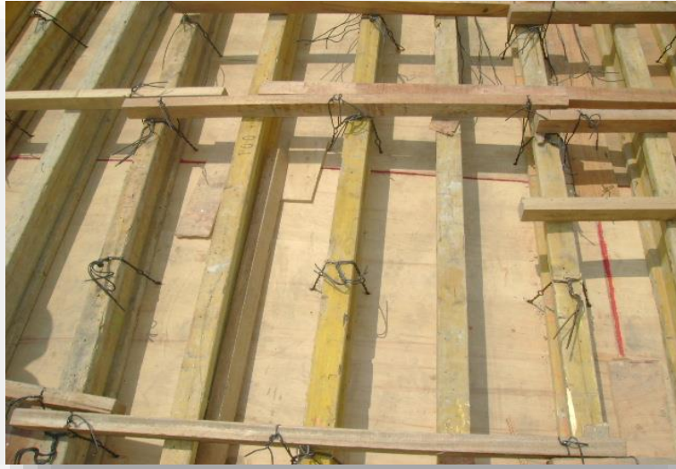
Foto 19: Encofrado exterior arriostrado con vigas principales y secundarias
