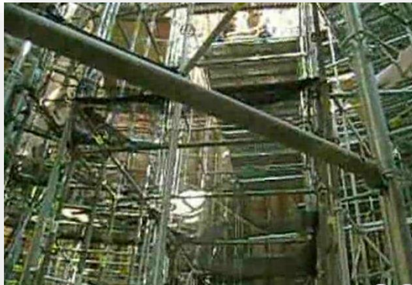
Foto 9: Alzaprimado Interior, Prueba de soporte de malla.
