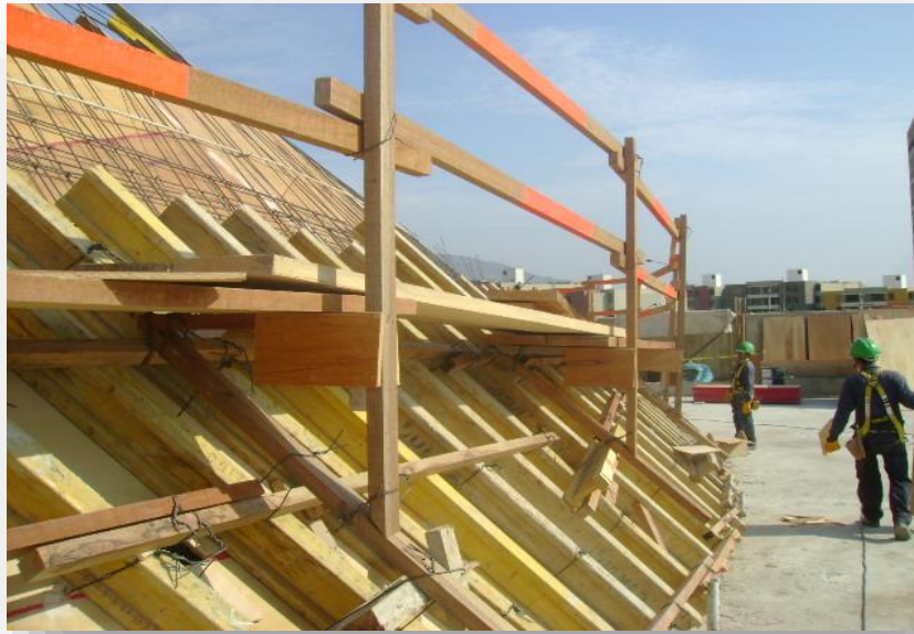
Figura 26: Plataformas de trabajo.
