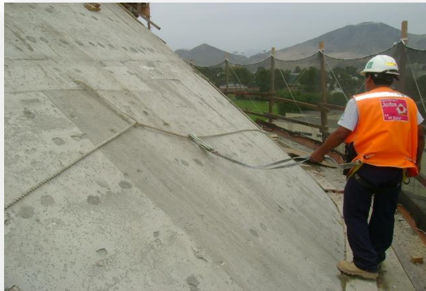
Foto 25: Trabajador con línea de vida y enganchado.
