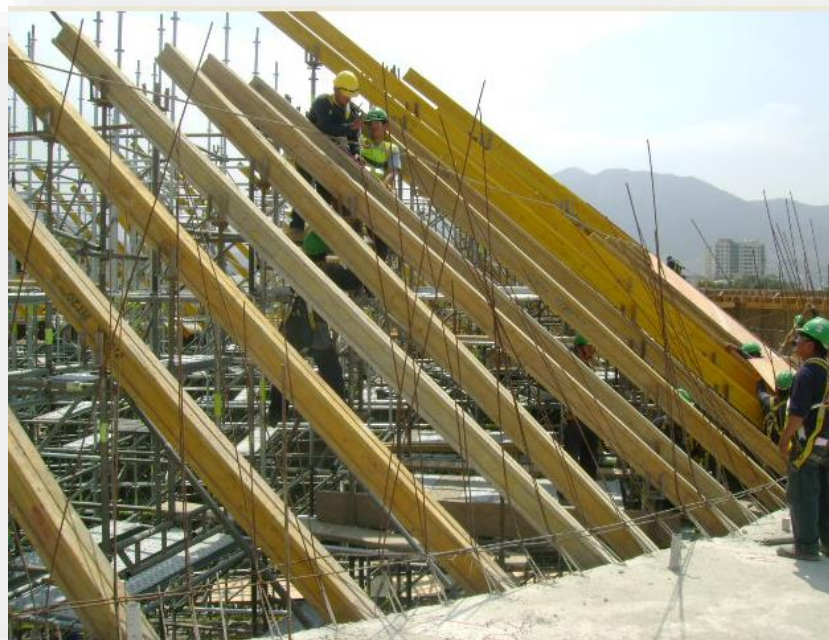
Foto 16: Se observan con cabezales que soportan las Vigas Ulmaflex
