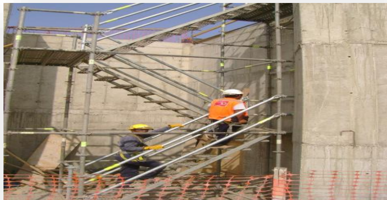
Foto 20: Imagen de escalera de acceso
