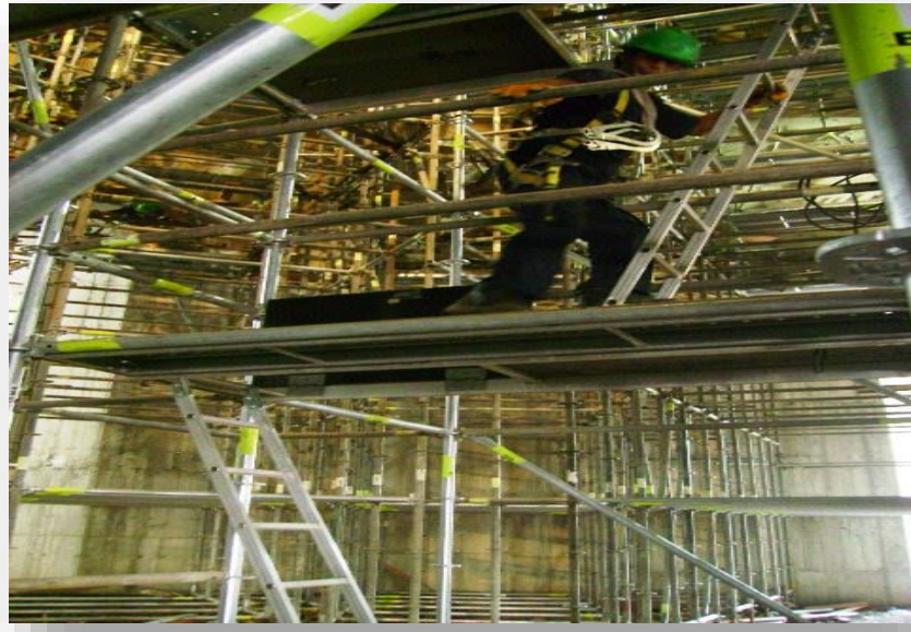
Foto 23: Escalera de acceso interior
