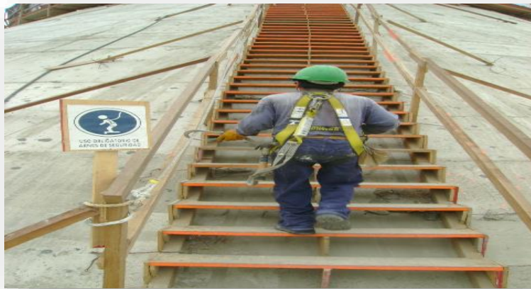
Foto 21: Escalera sobre superficie exterior desencofrada de Cúpula
