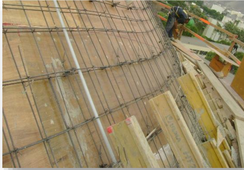
Foto 18: Acero 8mm, doble malla colocado
