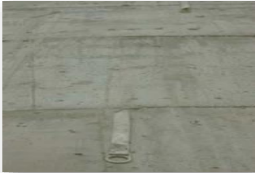
Foto 24: Muestra de Eslinga embebida en Concreto
