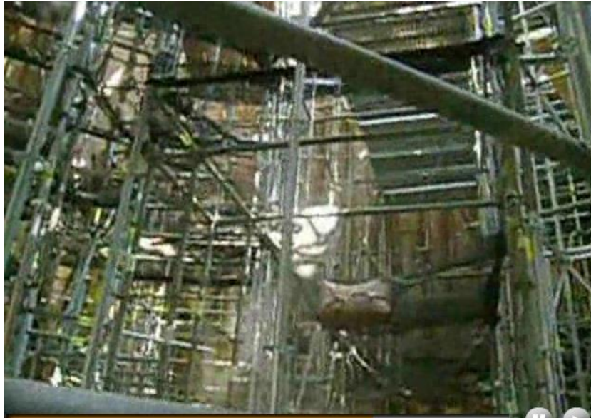
Foto 10: Mallas retienen bolsas de cemento.
