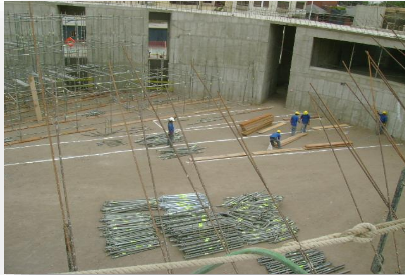
Foto 14: Arranque de alzaprisado en terreno.
