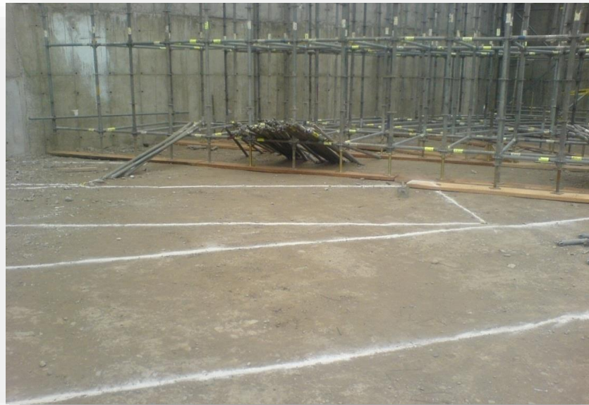
Foto 12: Muestran los ejes del diseño de proveedor marcado con yeso.
