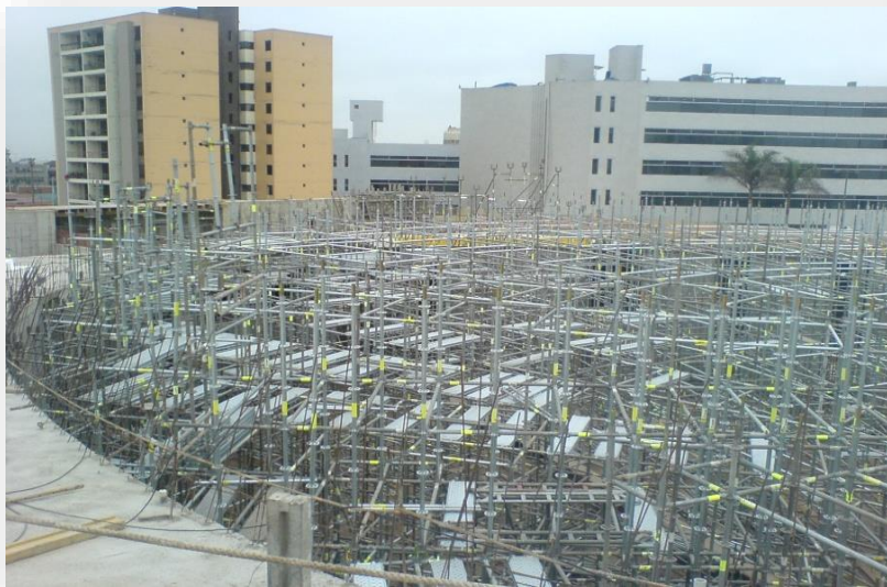
Foto 15: Nivel de Alzaprisado llega al nivel 0 de La Cúpula
