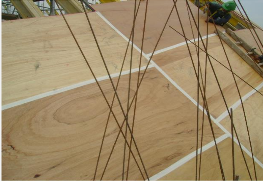
Foto 17: Encofrado interior listo unidos con cintas.
