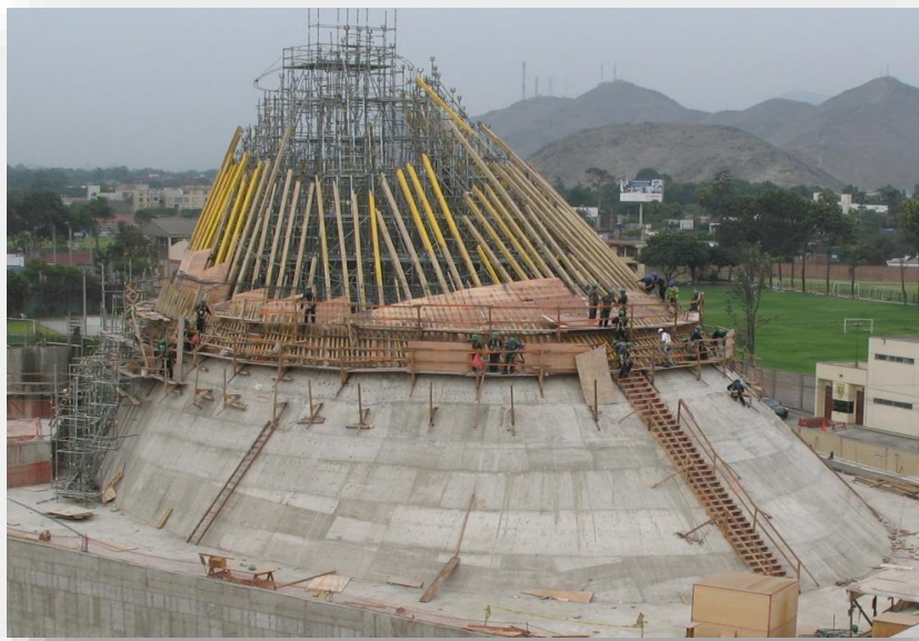
Foto 27: Vista de La Cúpula al 50% y las plataformas de trabajo.
