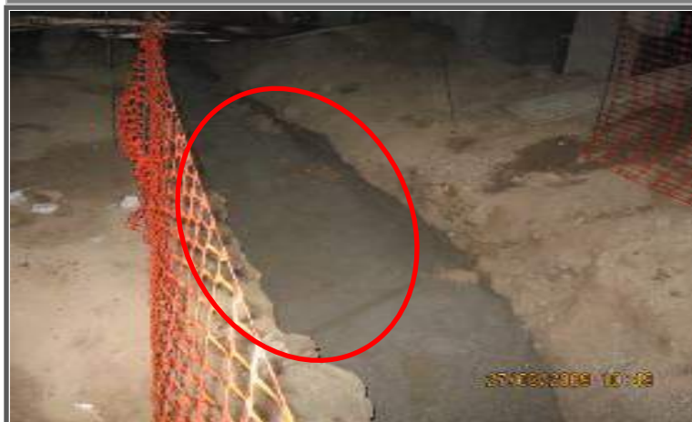
Figura 05-23: Relleno de la zona excavada.
