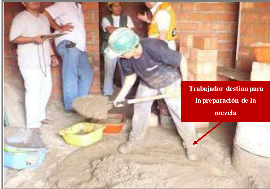
Figura 06-25: Trabajos de mezcla
