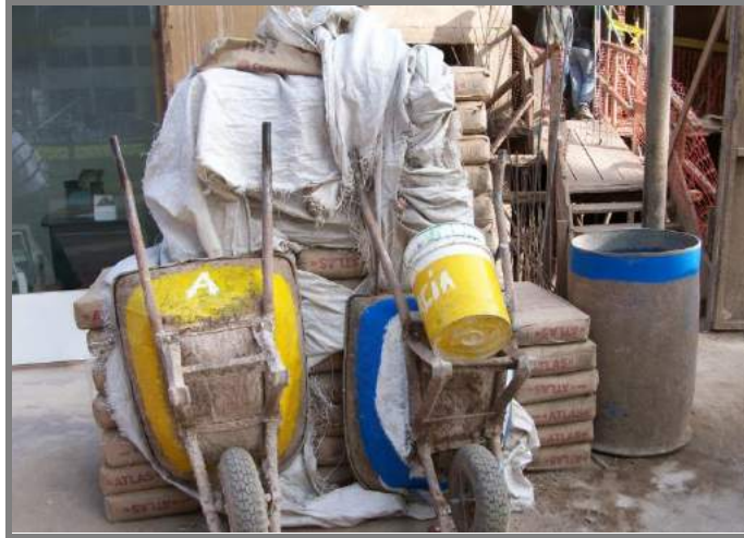
Figura 06-05: Equipos de trabajos con mediciones
