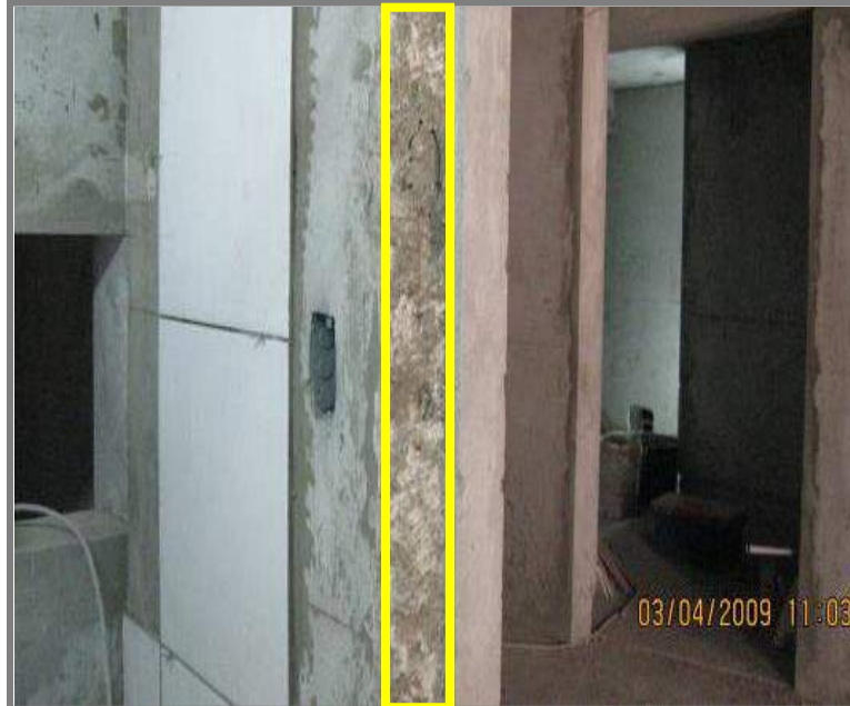
Figura 05-24: Zona Indicada como tarrajeo primario.
