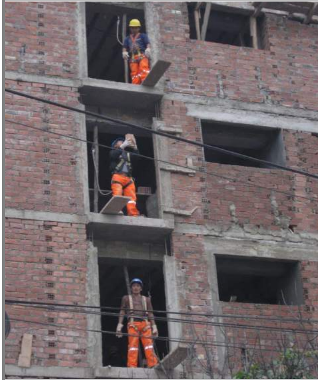
Figura 05-39: Habilitación de Ladrillos
