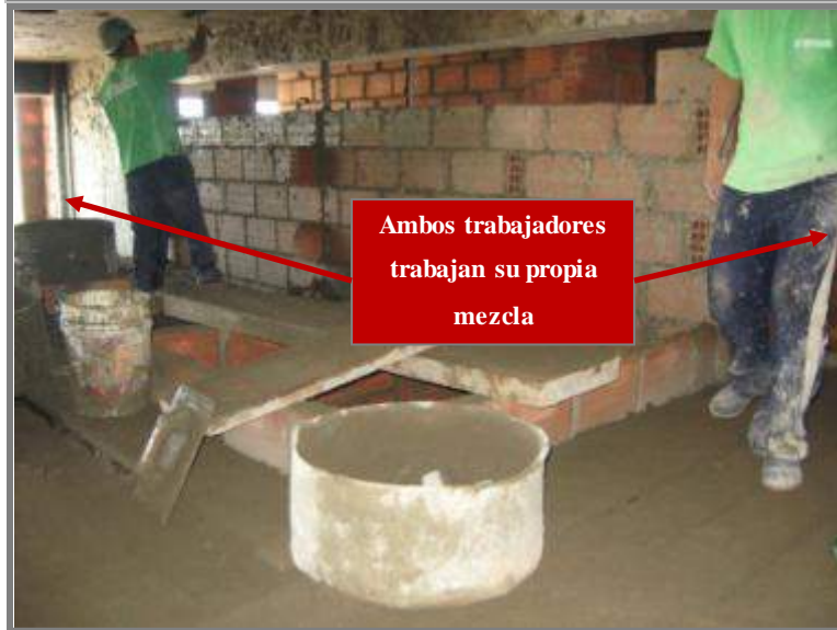
Figura 05-42: Trabajos de Albañilería
