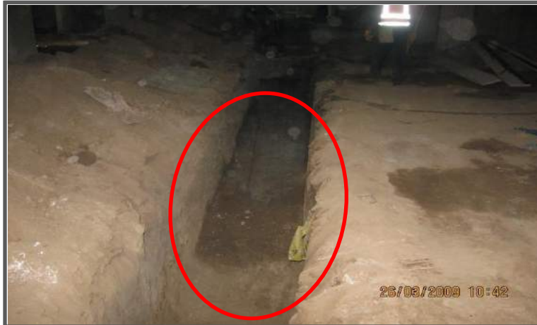
Figura 05-22: Excavación de canaleta.
