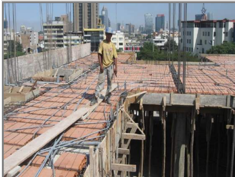
Figura 05-27: Sector 1 – Habilitación de losa.
