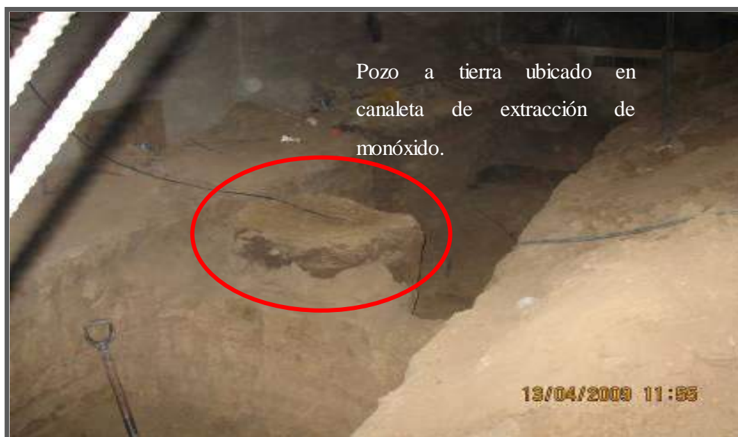
Figura:05-13: Pozo de tierra.
