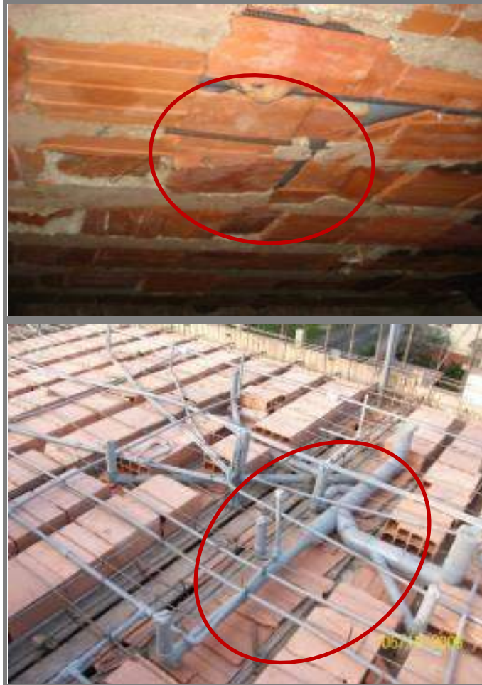
Figura 05-61 : Tubería en Losa
