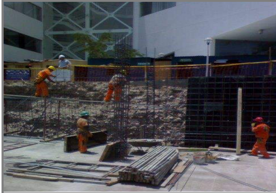
Figura 06-22: Traslado de Módulo Armado a Elementos Similares
