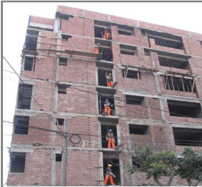
Figura 05-38: Habilitación de Ladrillos
