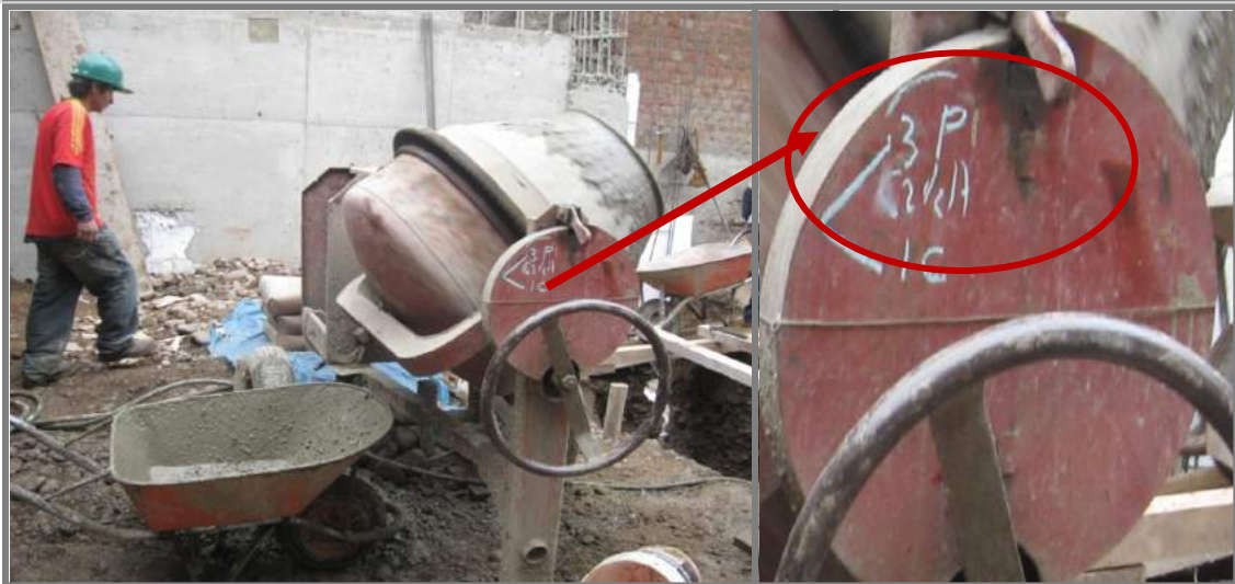
Figura 05-17: Dosificación de mezcla.
