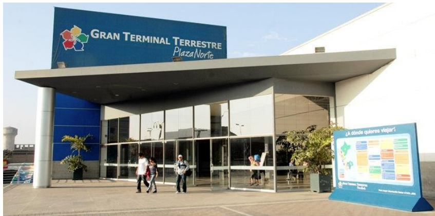
Imagen4.: Terminal Terrestre Plaza Norte
