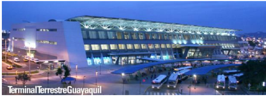
Imagen 6. Terminal terrestre de Guayaquil
