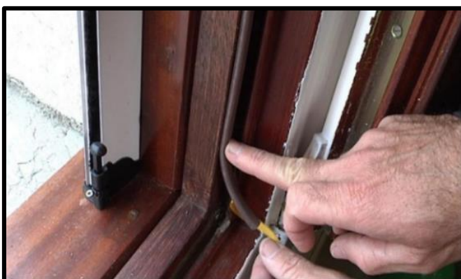
Colocación de burlete en ventana.
