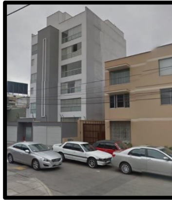
Multifamiliar, urb. Limatambo.
