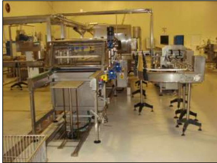
Figura N°2: Paletizadora de Coche Instalada
