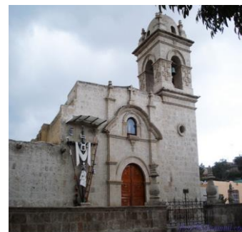
Fotografía 7 Iglesia de Quequeña
