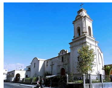
Fotografía 4 Iglesia de San Juan, distrito de Characato
