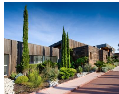
Ilustración 5 Hotel Casa del Mar
