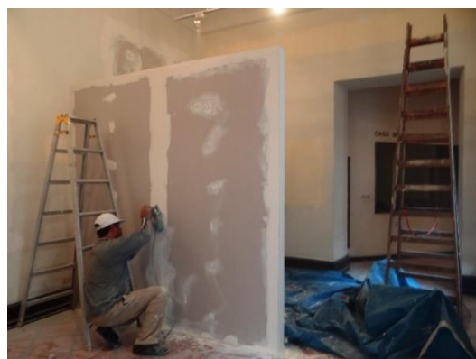
Trabajos en drywall en una de las salas del museo
