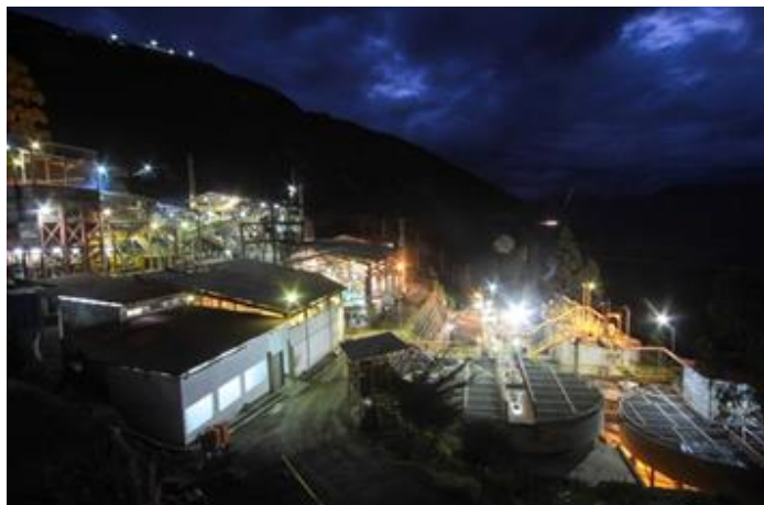
Figura 14 Vista nocturna Planta Marañón
