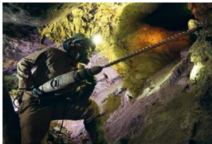
Figura 18 Perforación de frente
