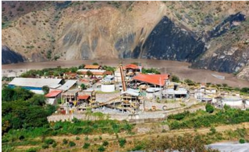
Figura 11 Planta Concentradora Marañón
