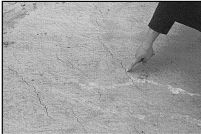
**Foto 1. Losa de concreto con fisuras por contracción plástica.**
