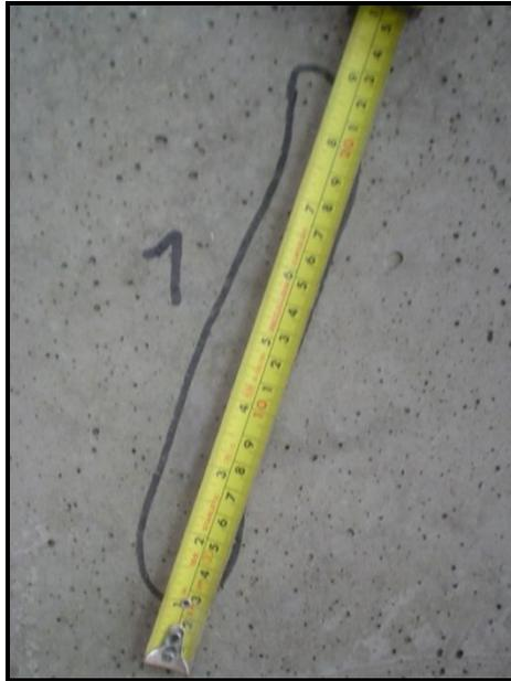
**Foto 17. Medición de la fisura.**
