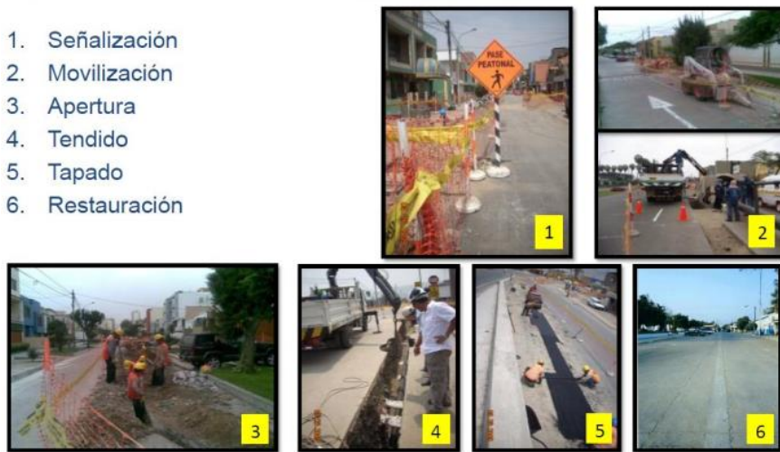
Figura 29. Tendido de redes urbanas de gas natural
