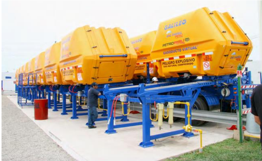
Figura 26. Intercambio de MAT con máquinas ST
