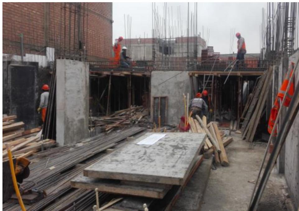
Figura N° 95.- Encofrado de elementos horizontales-sector
