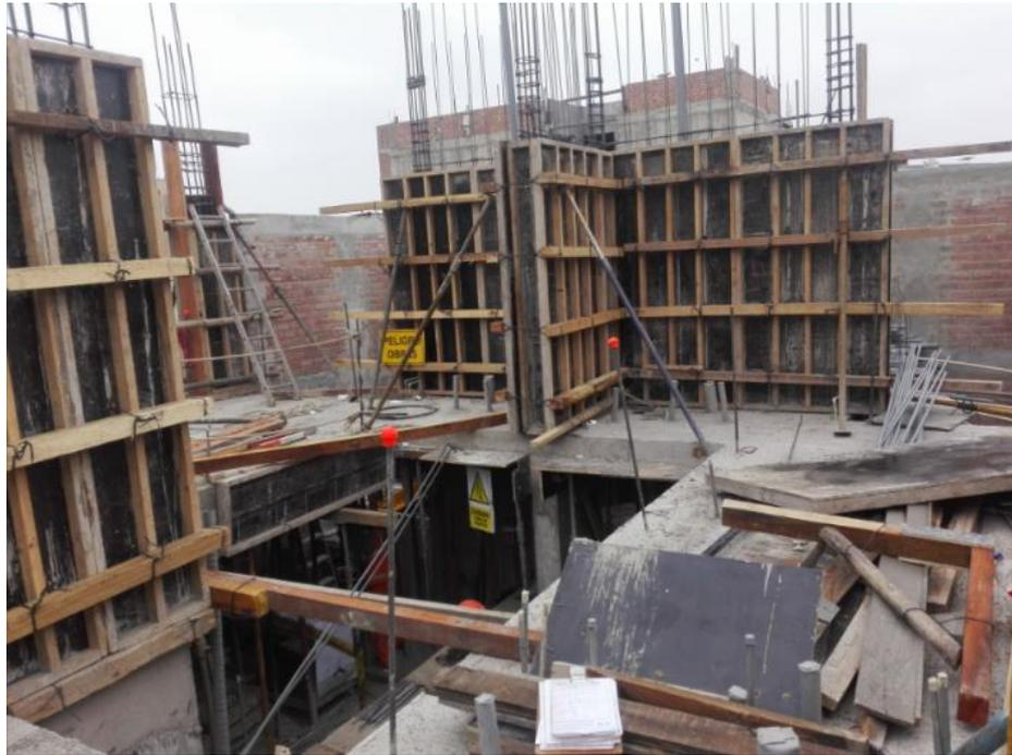
Figura N° 94.- Vaciado efectuado - espera de desencofrado
