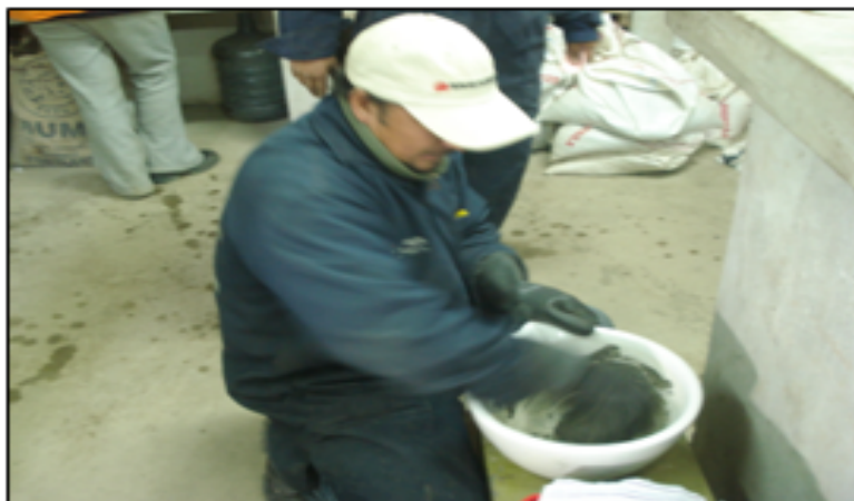
MEZCLA DE LA PASTA CEMENTO A HUMEDAD
