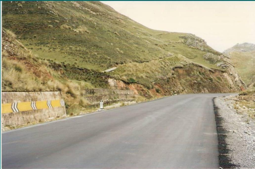
Carpeta asfáltica terminada, lista para que se aplique la señalización correspondiente
