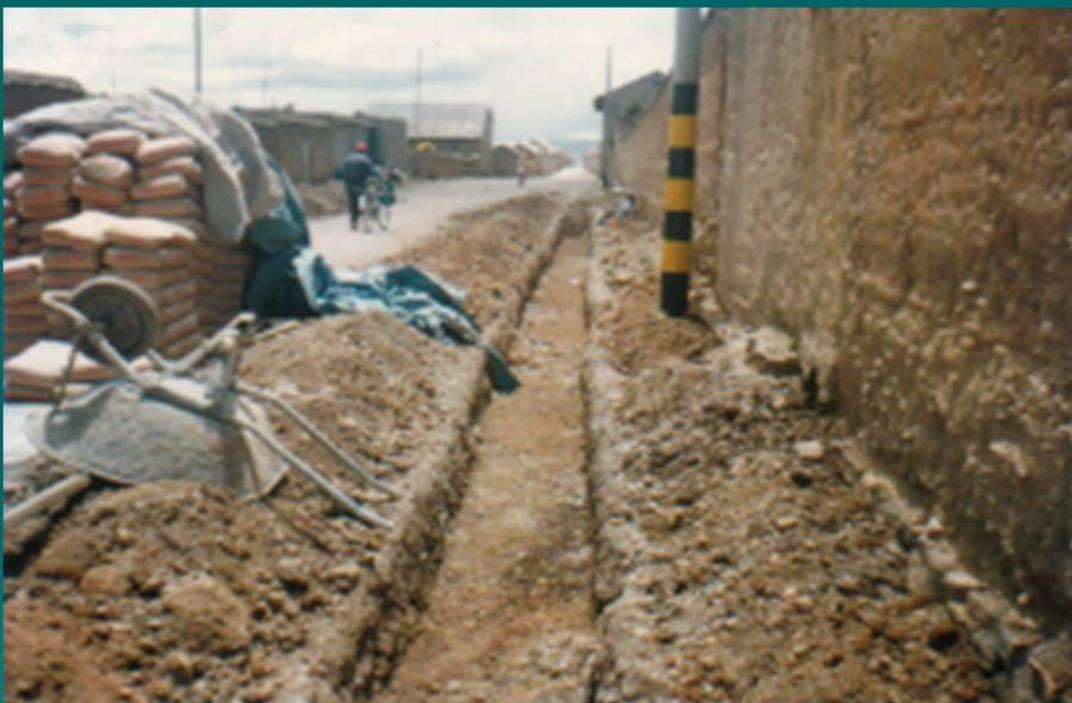
Excavaciones para el vaciado de concreto de cunetas en la Variante de Carhuamayo
