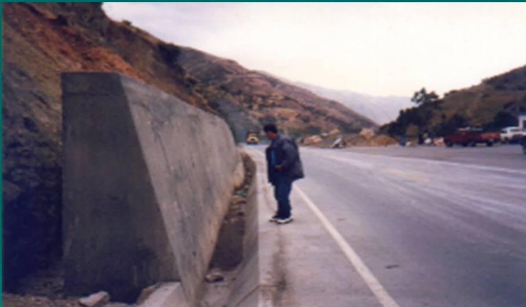
Muro de sostenimiento del talud del corte realizado para dotar a la plataforma del ancho necesario, visto en seccion
