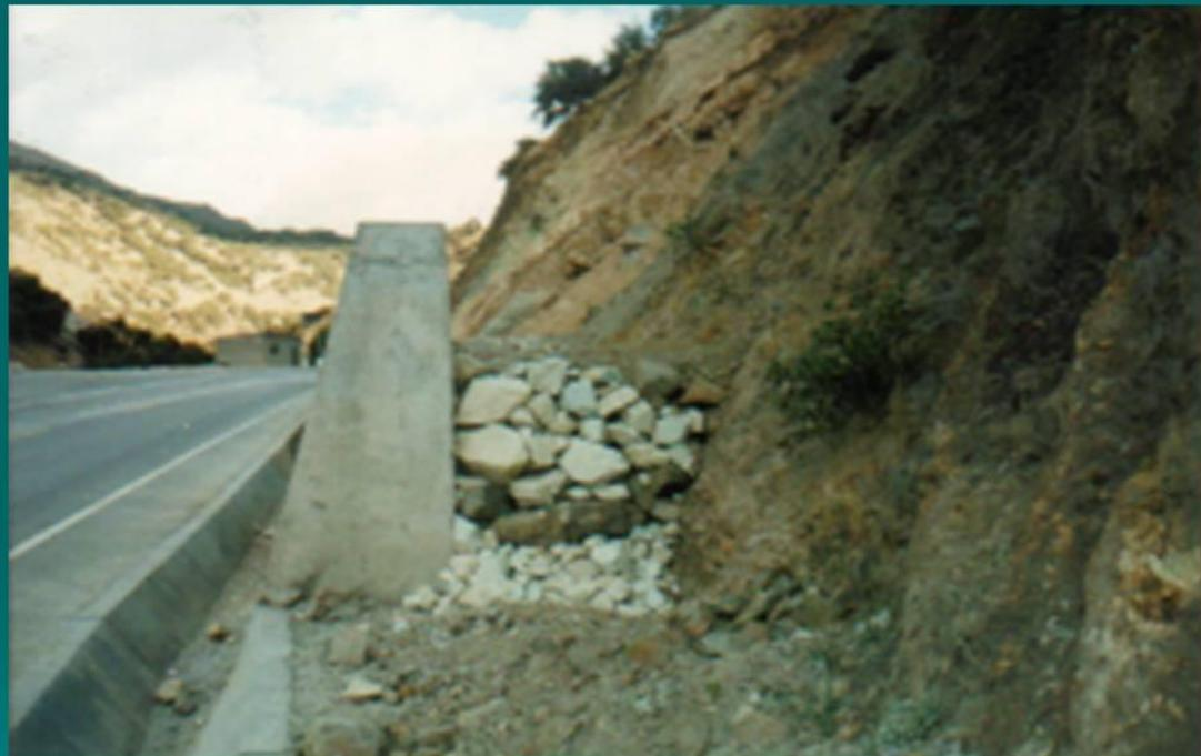
relleno del muro con material adecuado, de acuerdo a las especificaciones técnicas
