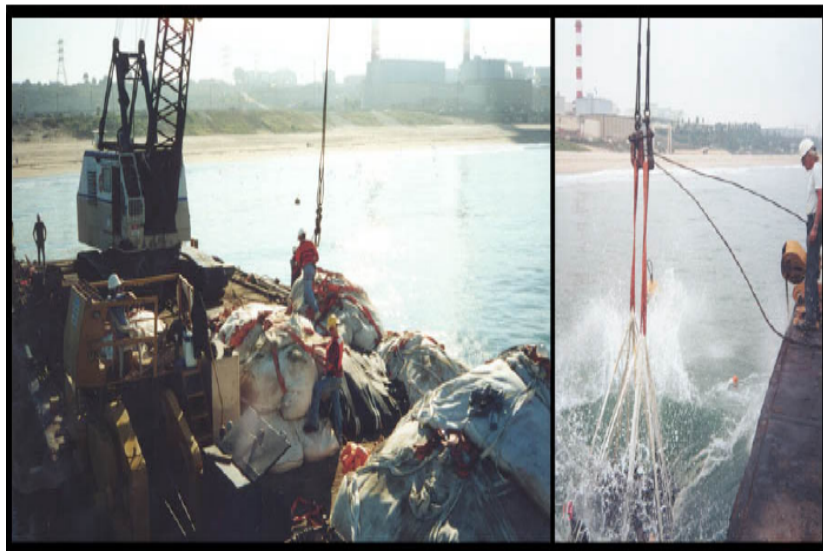
Figura 8. Colocación de las bolsas de geotextil in situ desde la barca
