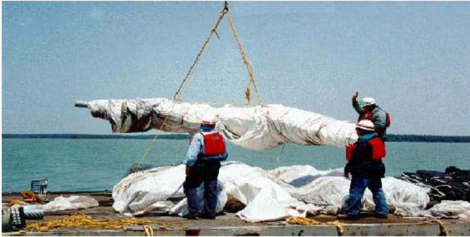
Fig. 29. Embarcación de los geotextiles para su posterior relleno
