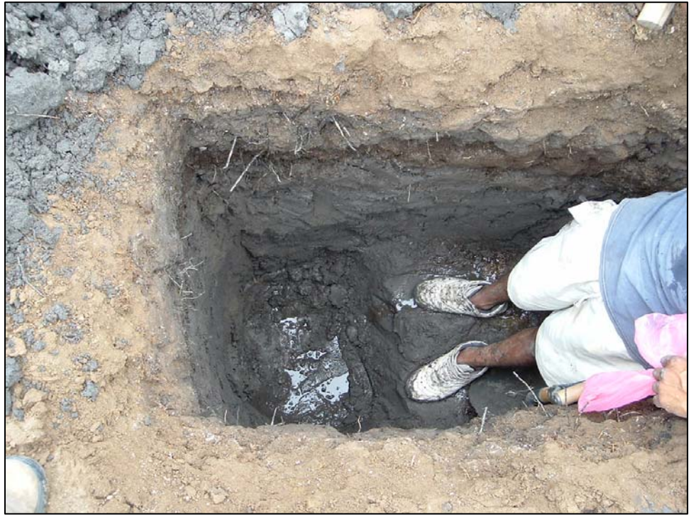
EJECUCION DE CALICATA EN BUENAVISTA- VALLE DE LURÍN.
