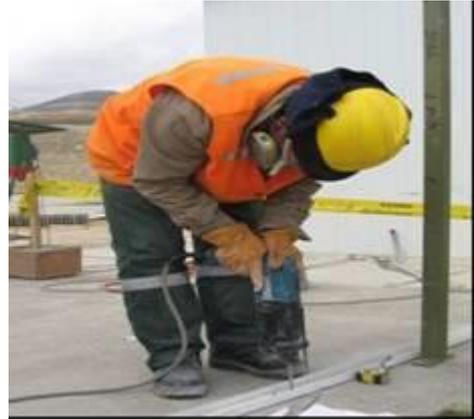
Una vez colocada la columna, los pernos de anclaje tipo cuña o de expansión serán ajustados con llaves de boca y corona o con rache y dados hexagonales, debiéndose realizado por lo menos un chequeo aleatorio del torque aplicado a los mismos de acuerdo al manual del fabricante.
