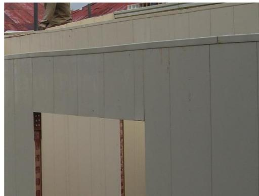
En esta partida se instala el marco tapa de los muros, este marco se coloca sobre la platina, para dar un buen acabado a los muros.
