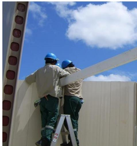
Las vigas se asientan sobre las columnetas, que llevan dos orejas para sostenerlas, las vigas se instalan in situ. El muro RBS se destaja a medida de la viga para que esta pueda encajar.
