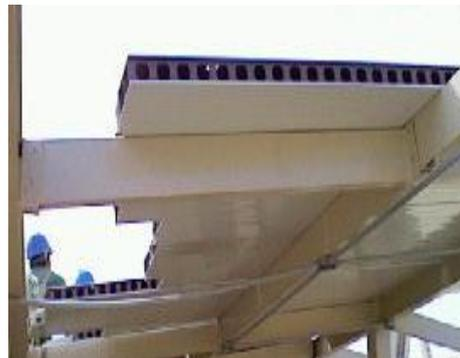
Para empezar con la instalación de techo, debe haberse terminado el montaje de los muros hasta la colocación del marco tapa pendiente, a la vez la instalación de vigas, pórticos, tijerales que se mencionen en los planos.
