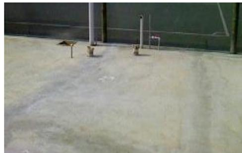
Como podemos observar en la Fotografía 46, Antes de vaciar la losa se tienden las tuberías de agua y desagüe según lo especificado en la sección 4.1.6, para que al término del vaciado de concreto la losa se quede con las salidas visibles de agua y desagüe y continuar con la instalación sanitaria mas adelante.
