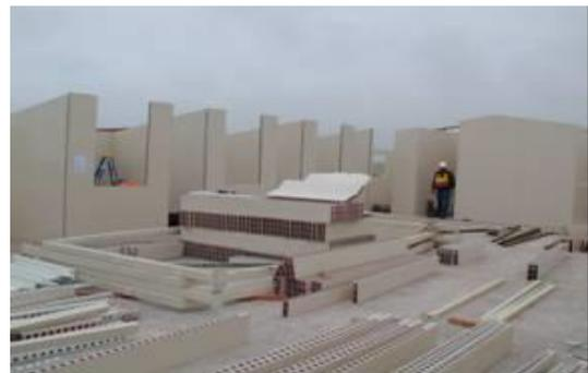
Para agilizar el armado de los muros es necesario que el material este cercano al lugar de la colocación de estos.
