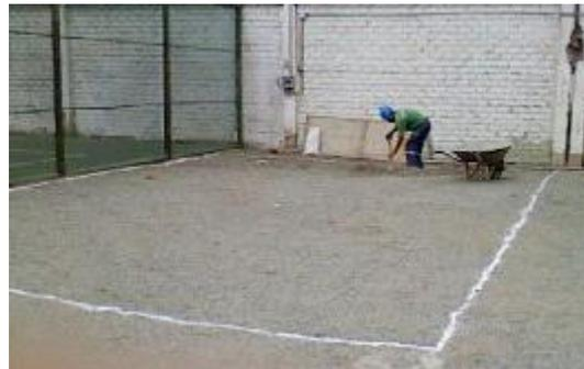
La partida de Trazo y replanteo es lo primero que se realiza después de la limpieza de terreno, Se delimita el terreno y se ubican los ejes de la construcción.
