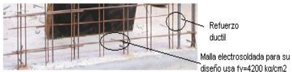
En edificios de mas de tres pisos, debe proveerse del refuerzo necesario para garantizar una resistencia nominal a flexo compresión del muro por lo menos igual a 1,2 veces el momento de agrietamiento de su sección. Esta disposición podrá limitarse al tercio inferior del edificio y a no menos de los dos primeros pisos.
