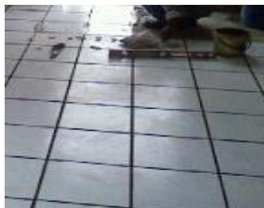
Para comenzar esta partida primero se debe hacer una limpieza general en toda el área donde se pondrá el piso, además de haber terminado con la instalación del techo. Se procede a la puesta del piso cerámico, utilizando el pegamento en polvo, posteriormente agregándole el fraguado respectivo.
