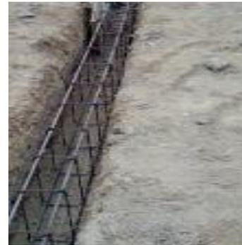
Esta partida encierra el refuerzo estructural que lleva la viga, los materiales ya mencionados se habilitan y se realizan los estribos y la viga propiamente dicha.
