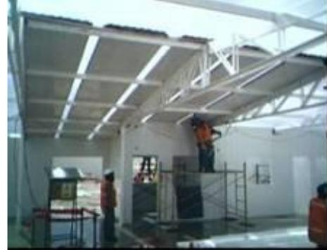
**Fotografía 35:** Alineación de paneles de techo
