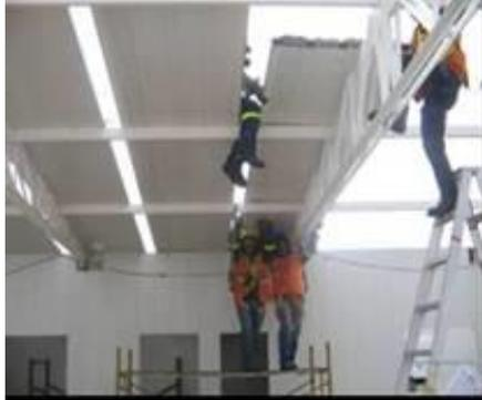
**Fotografía 34:** Instalación de paneles de techo
