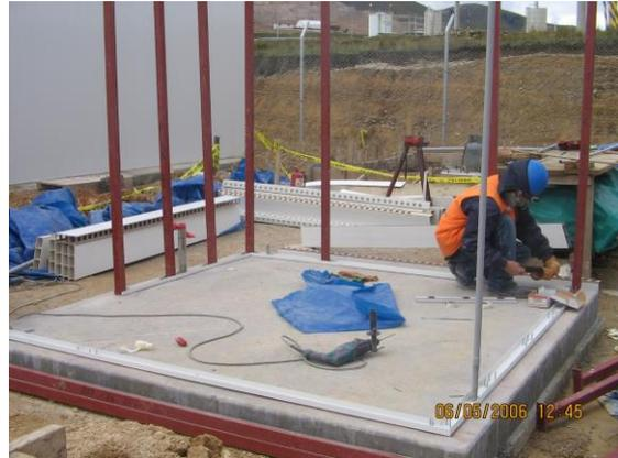
**Figura 6.3.** Detalle de platinas en base de columnas
