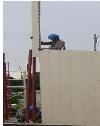
Una vez colocado el marco básico y las columnetas se procede a la instalación del muro RBS, se acostumbra iniciar la instalación de los muros RBS por la esquina, es decir, el primer paso sería instalar el esquinero. Durante el proceso de montaje de paneles muro RBS, se debe tener especial cuidado en no causar deterioros al marco básico inferior, para lo cual será necesario auxiliarse de elementos que permitan abrir las alas de éste.
