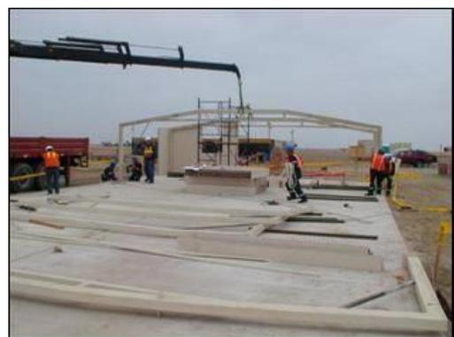
**Fotografía 23:** Instalación de pórticos
