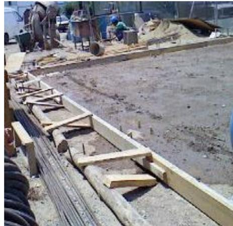
El encofrado de losa se realiza para que el vaciado de concreto se ciña a la medida designada y limitada por el encofrado.
