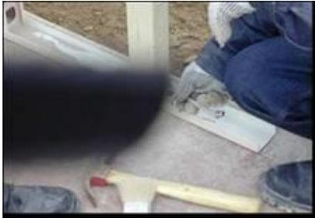
**Fotografía 17:** Colocación de Pernos de anclaje
