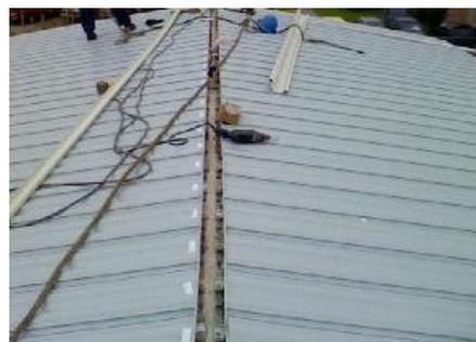
Una vez terminado el cableado eléctrico e instalada la cumbrera, se pueden colocar las tejas, las cuales empalman con el techo con el sistema machihembrado, luego se aseguran las tejas con tornillos autorroscantes y arandelas forradas con neopreno.
