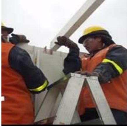
**Fotografía 26:** Instalación de vigas tijerales
