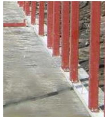
Una vez instalado el marco básico, se distribuyen las columnetas según la dispuesto por los planos de distribución de columnetas (Véase anexo Planos columnetas). Estas columnetas se anclan a la losa de concreto con unos pernos de anclaje tipo cuña 1/4"x3/4, cada columneta lleva 4 pernos. Estas columnetas se colocan de 1 a 1,5 m, además se colocan columnetas donde se necesita apoyar algún peso adicional al peso de la estructura, como en el caso de los aparatos sanitarios.
