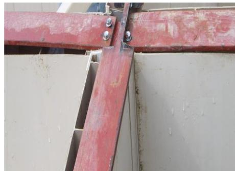
Cuando se termina la instalación de los muros, se procede con la instalación de las platinas que permitirán que las vigas se empernen, estas platinas se atornillan con autoperforantes N° 8x1", sobre los muros.
