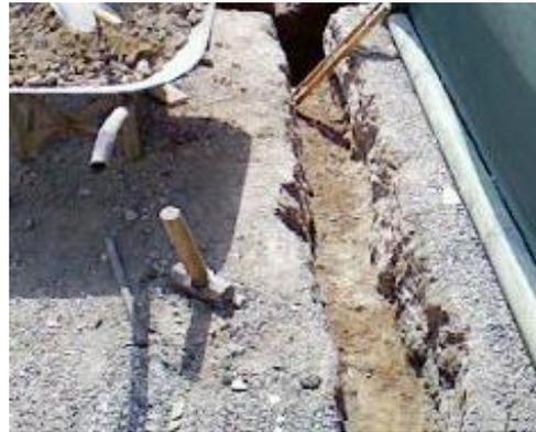
En esta partida se realiza la excavación de las vigas perimetrales de la losa. En esta obra el diseño indicaba vigas de (0,3x0,3).
