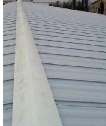
Después de terminar con la instalación de la teja y después de haber verificado que las instalaciones eléctricas funcionan correctamente, se procede a instalar la tapa de cumbrera encima de la teja deslizando la tapa de cumbrera por las renuras de las tejas.
