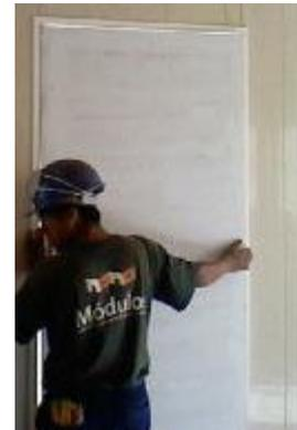
Para proceder con esta partida se deberá haber acabado con la instalación de los paneles de muros a ambos lados del vano, con su debida columneta según los planos, además de haber culminado con la colocación de la viga dintel.
