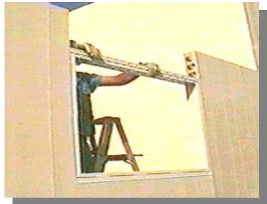
Para colocar el marco superior de la ventana, se insertara de canto entre los conectores y posteriormente se girara para su correcto ensamble.
