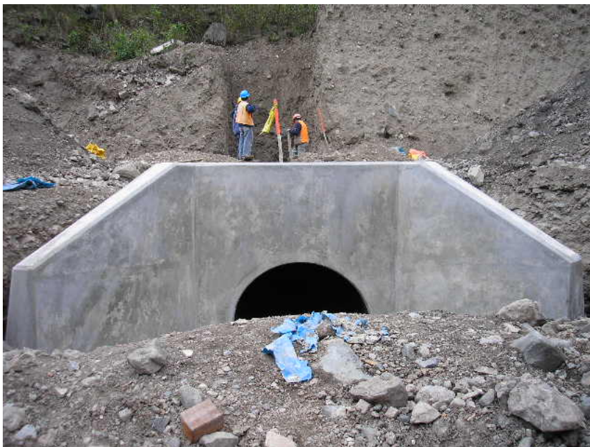
CONSTRUCCION DE ALCANTARILLAS MC 1*1 - 1.5*1.5
