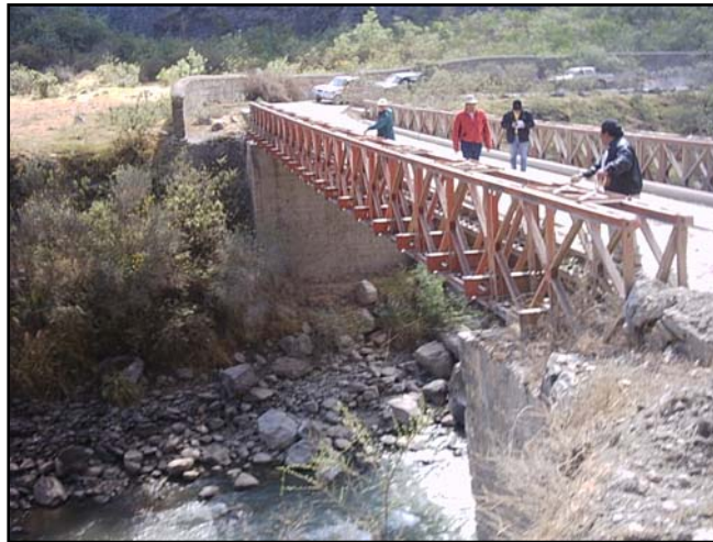
Puente Bélis aguas arriba, margen derecha
