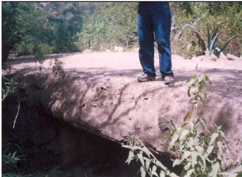
Pontón 98+980.00 Vista aguas arriba.
