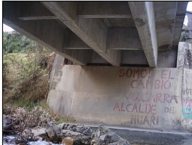
Puente Huayochaca Km 103+894.40
