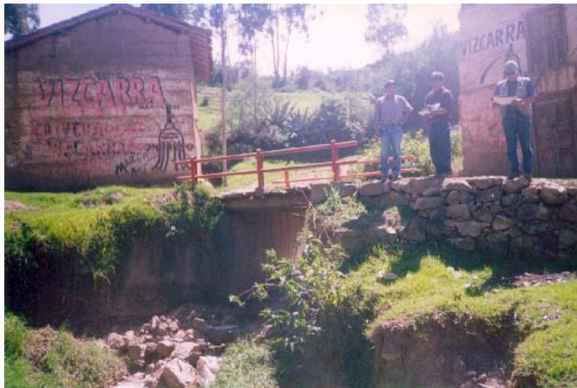
Pontón 104+028 Vista aguas arriba
