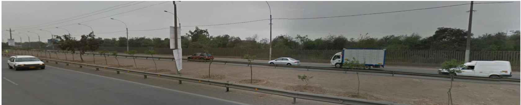
AUTOPISTA RAMIRO PRIALE
