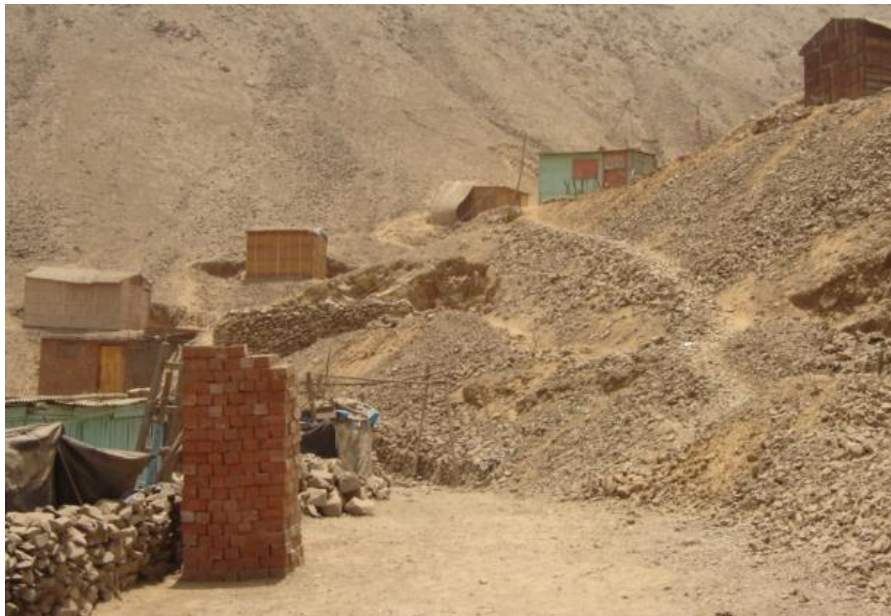
Figura 3.4: Cimentación con muro de piedra tipo pirca A. H. Huaycan, Distrito de Ate Vitarte.
