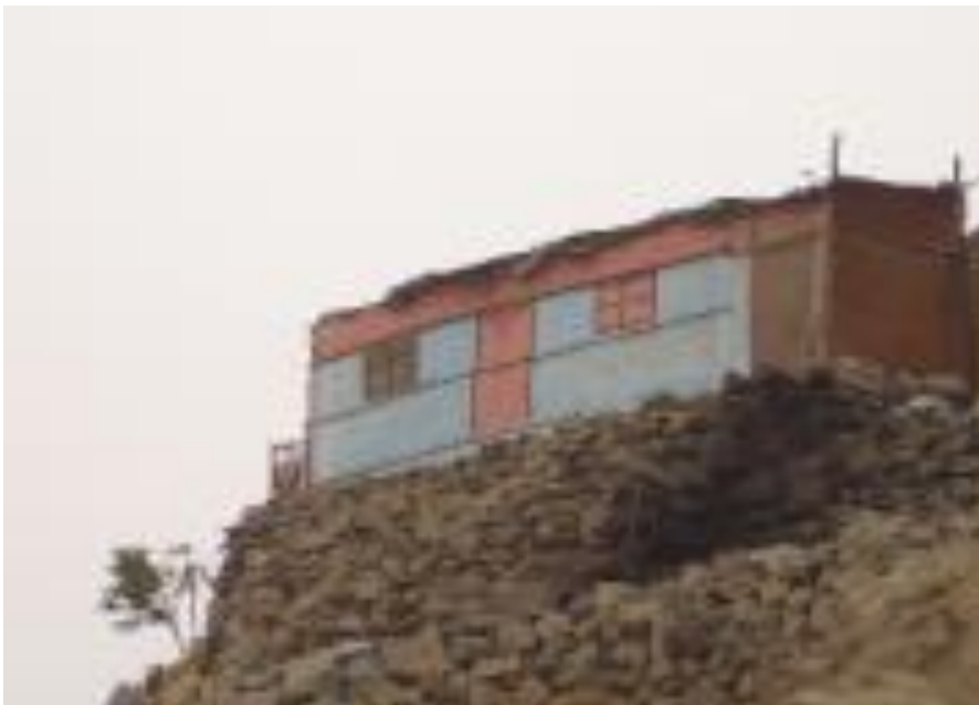
Figura 3.22: Cimentación con muro de piedra tipo pirca A. H. Andrés Avelino Cáceres, Distrito de San Juan de Lurigancho.
