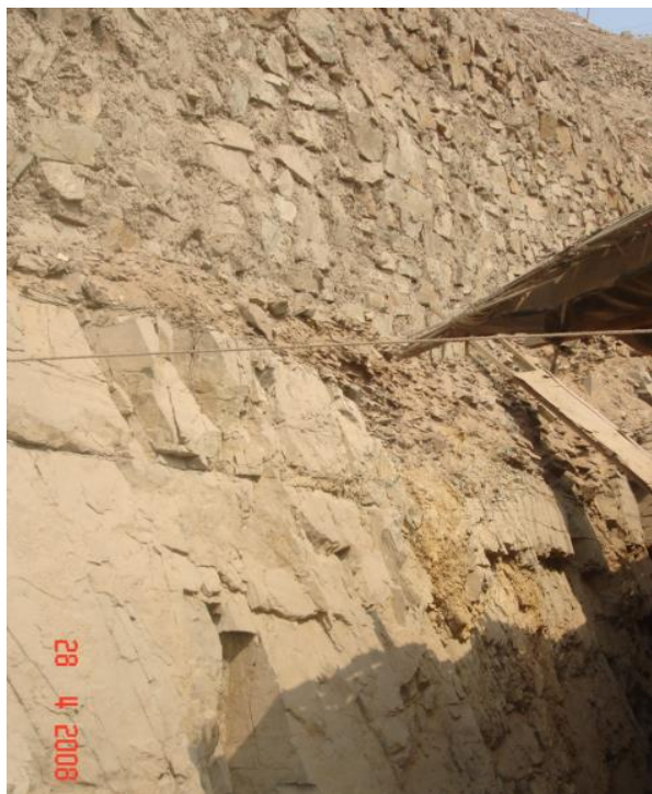
Figura 7.28: Corte de la roca en la zona de deslizamiento.
