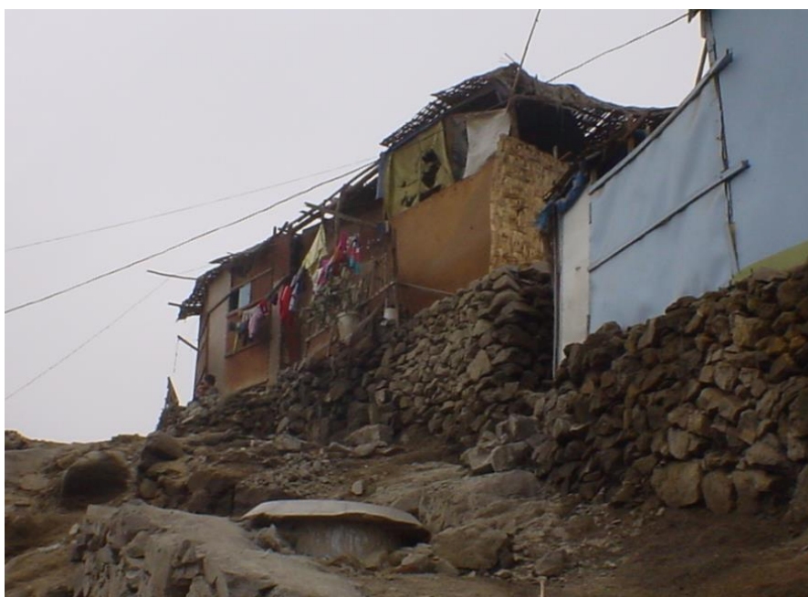
Figura 3.14: Cimentación con muro de piedra tipo pirca A. H. Cruz de Chalpón, Distrito de San Juan de Lurigancho.
