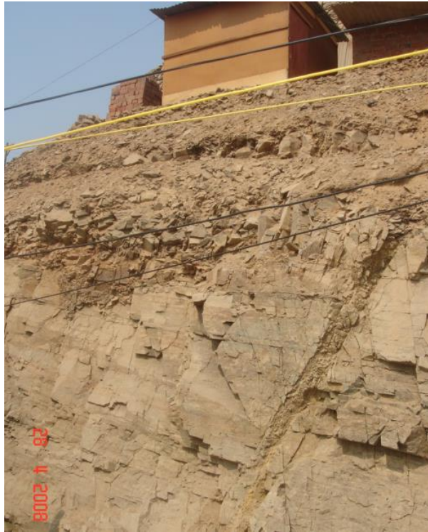
Figura 7.27: Corte de la roca en la zona de deslizamiento.
