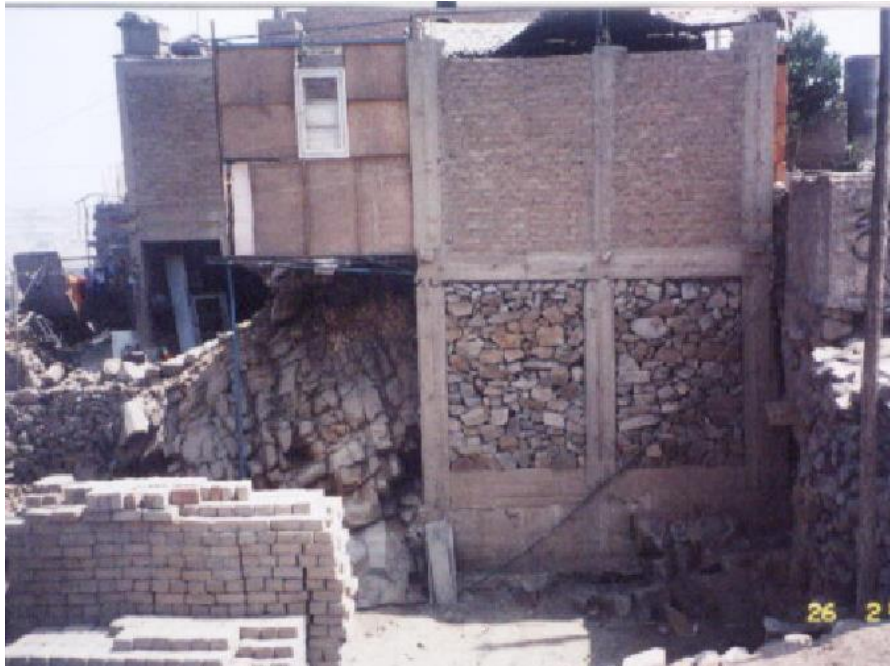
Figura 3.27: Cimentación con muro de piedra tipo pirca A. H. 3 de Mayo, Distrito de San Martín de Porres.
