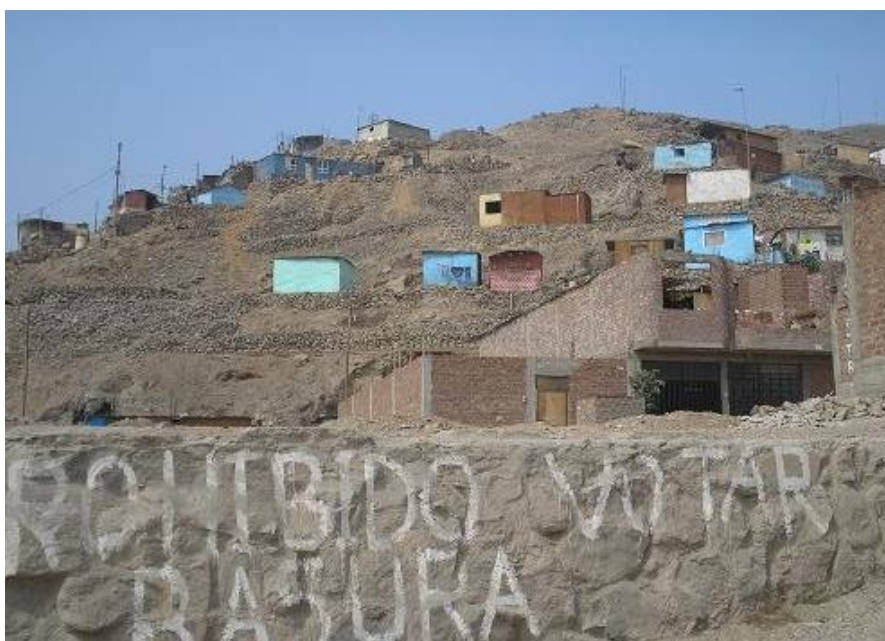
Figura 3.18: Cimentación con muro de piedra tipo pirca A. H. Las Terrazas, Distrito de San Juan de Lurigancho.
