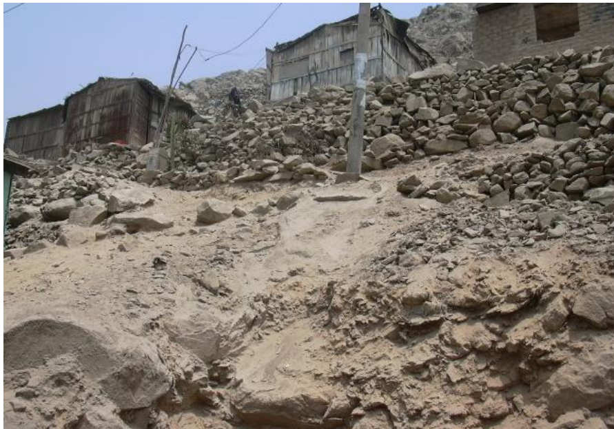
Figura 3.10: Cimentación con muro de piedra tipo pirca A. H. Huaycan, Distrito de Ate.
