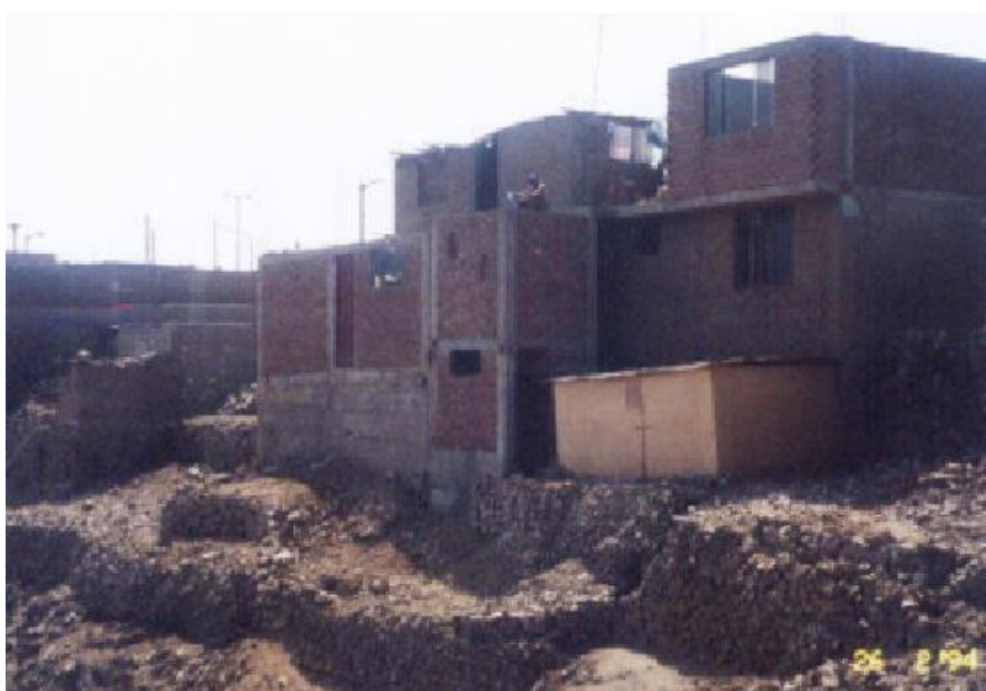
Figura 3.26: Cimentación con muro de piedra tipo pirca A. H. 3 de Mayo, Distrito de San Martín de Porres.
