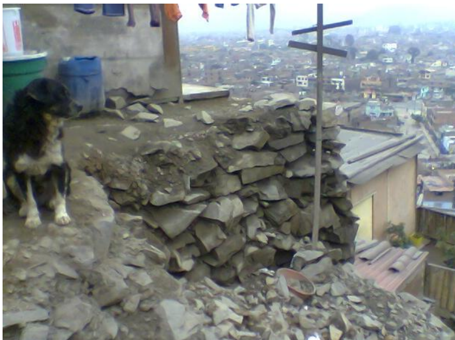
Figura 3.24: Cimentación con muro de piedra tipo pirca A. H. Avelino Cáceres, Distrito de San Juan de Lurigancho.
