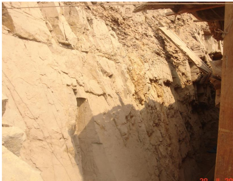
Figura 7.26: Corte de la roca en la zona de deslizamiento.
