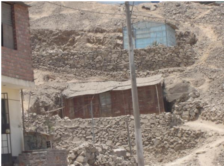
Figura 3.6: Cimentación con muro de piedra tipo pirca A. H. Huaycan, Distrito de Ate Vitarte.
