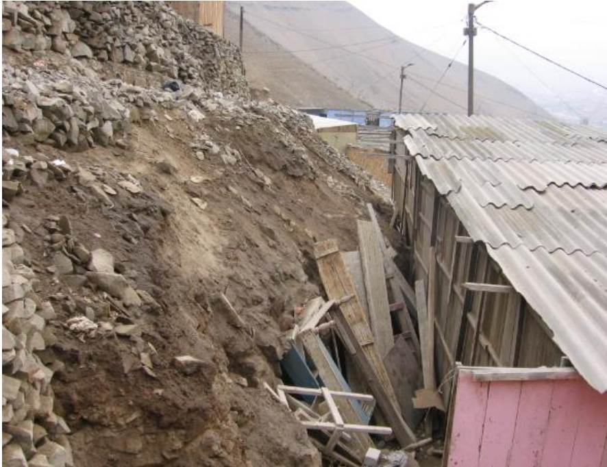
Figura 3.31: Cimentación con muro de piedra tipo pirca A. H. Villa 2000, Distrito de Ventanilla.
