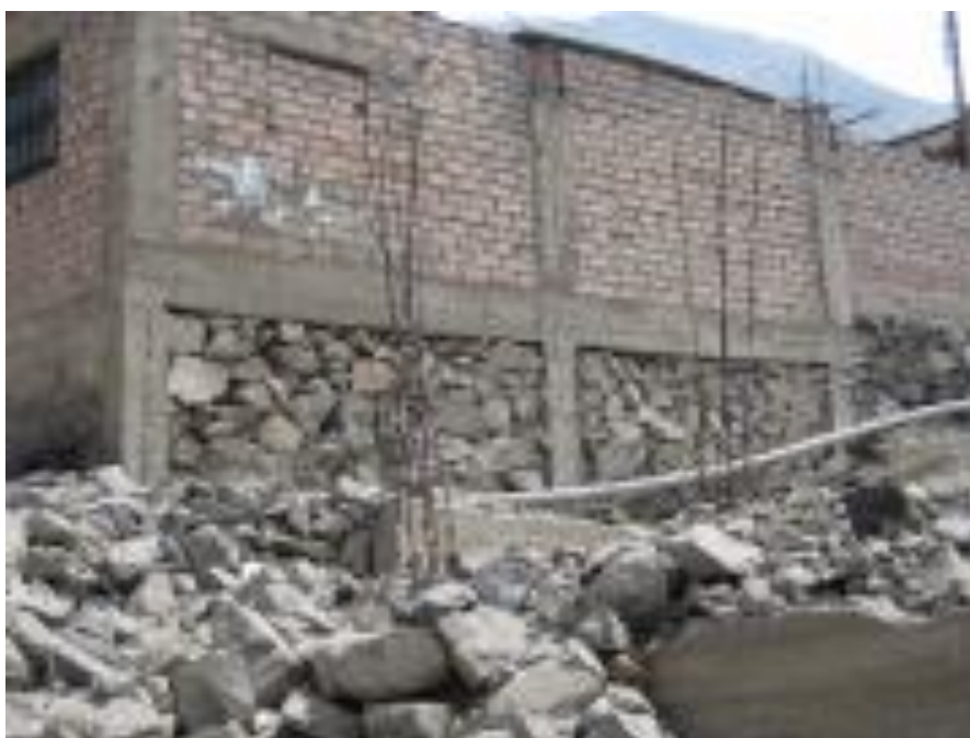
Figura 3.12: Cimentación con muro de piedra tipo pirca A. H. 19 de Abril, Distrito de San Juan de Lurigancho.
