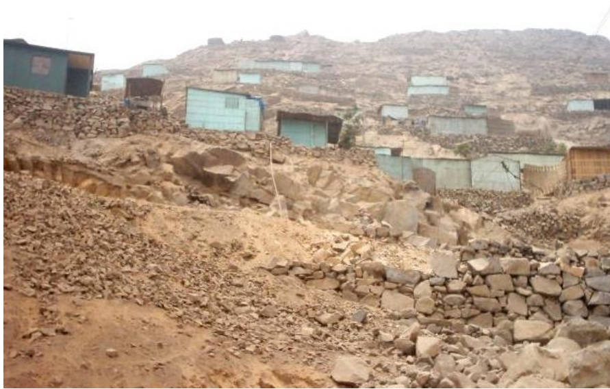
Figura 3.9: Cimentación con muro de piedra tipo pirca A. H. Huaycan, Distrito de Ate.
