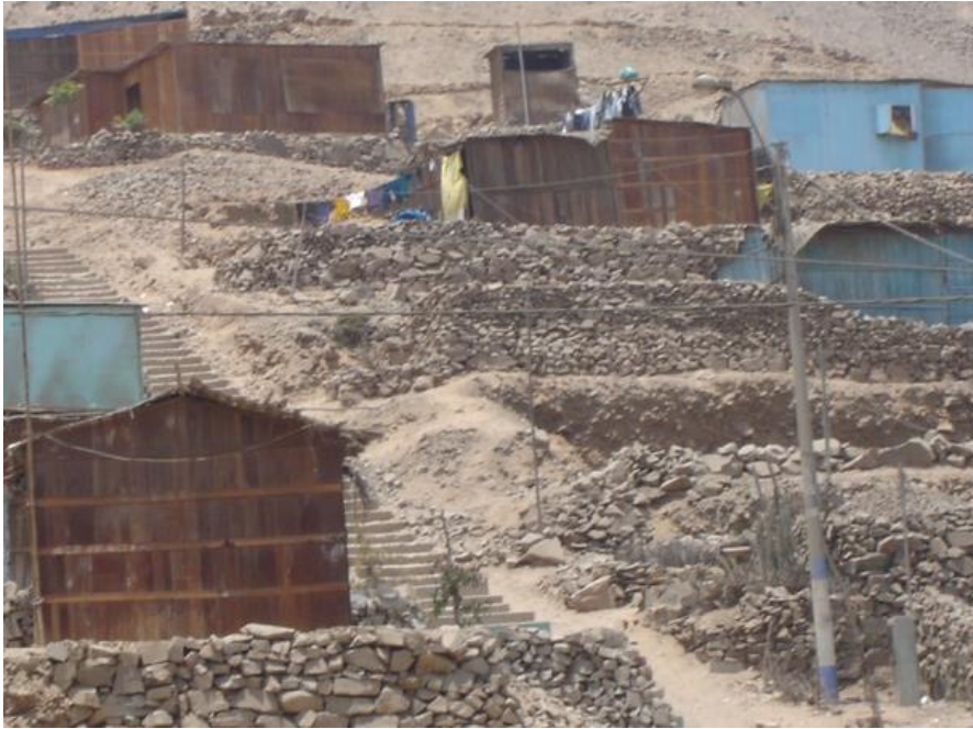
Figura 3.7: Cimentación con muro de piedra tipo pirca A. H. Huaycan, Distrito de Ate Vitarte.
