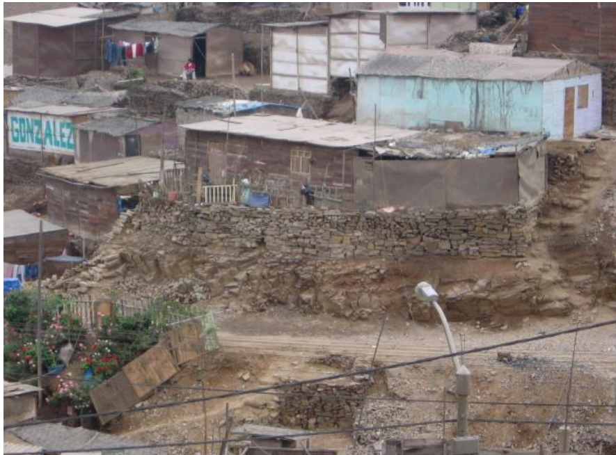
Figura 3.29: Cimentación con muro de piedra tipo pirca A. H. Kenyi Fujimori, Distrito de Ventanilla.
