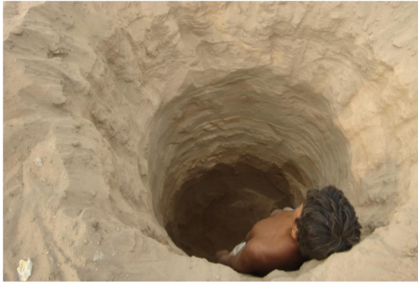
Figura 2.4: Calicata y estratigrafía del suelo. A.H. Los Angeles, Distrito de Ventanilla.
