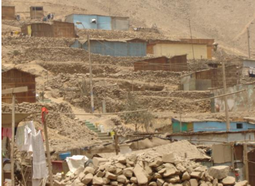
Figura 3.3: Cimentación con muro de piedra tipo pirca A. H. Huaycan, Distrito de Ate Vitarte.
