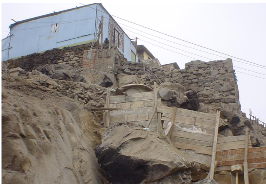
Figura 3.13: Cimentación con muro de piedra tipo pirca A. H. Cruz de Chalpón, Distrito de San Juan de Lurigancho.
