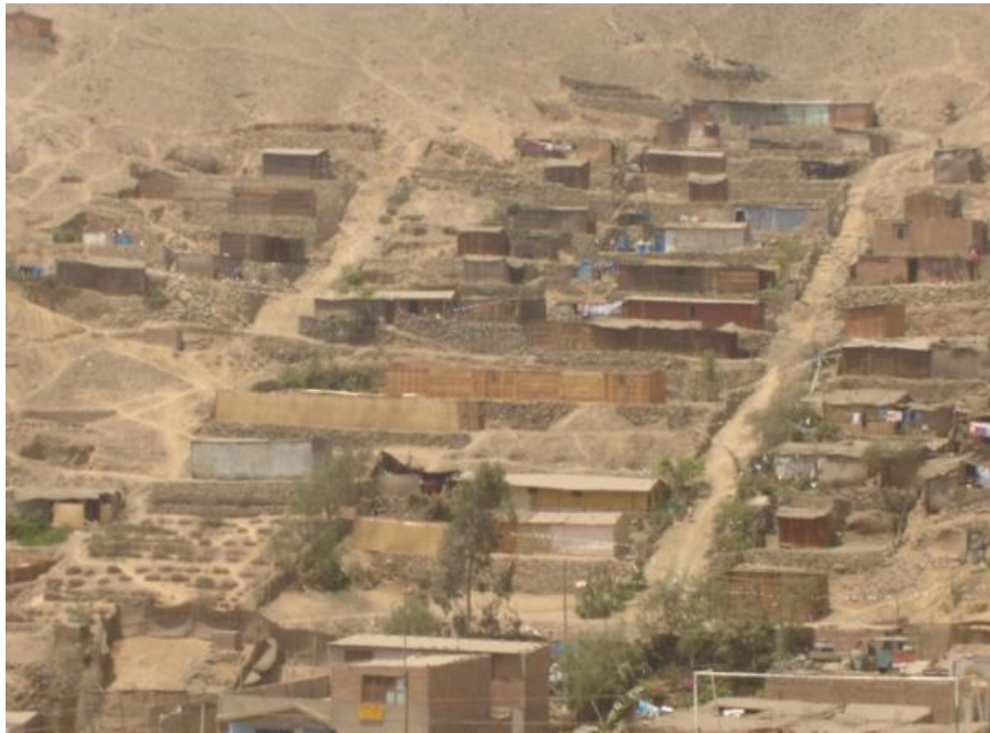
Figura 3.5: Cimentación con muro de piedra tipo pirca A. H. Huaycan, Distrito de Ate Vitarte.
