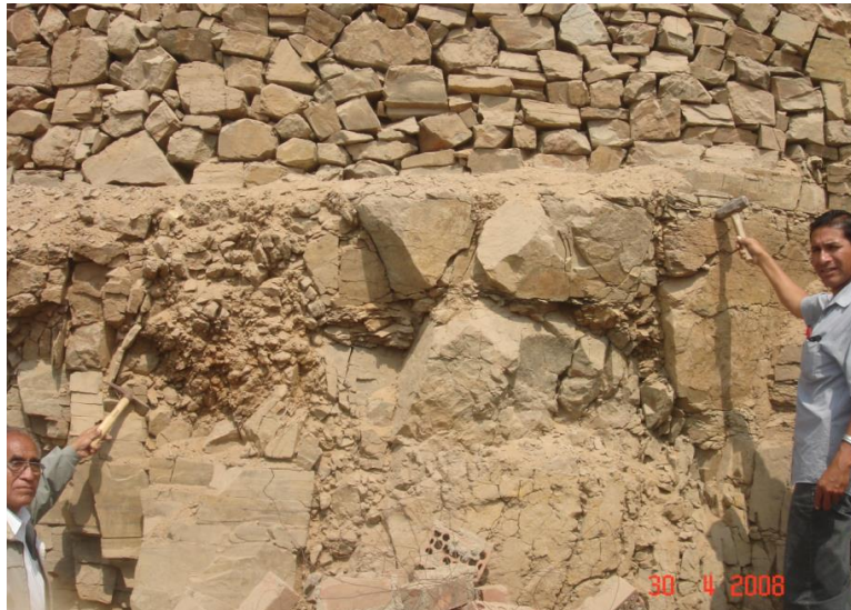
Figura 7.17: Ing. Tumialán en visita a zona de deslizamiento.
