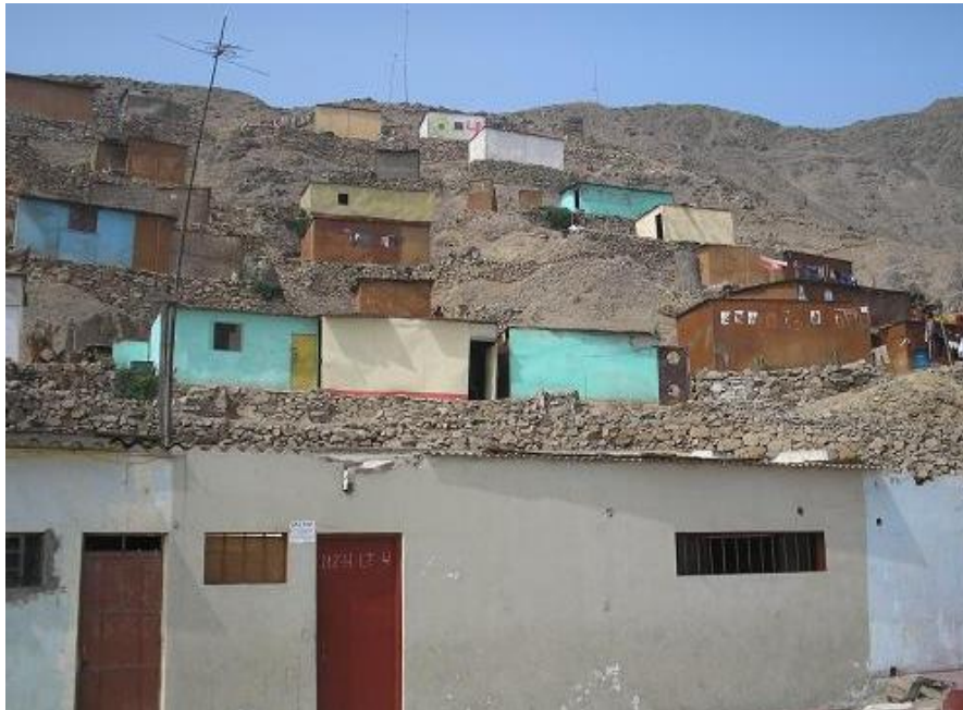
Figura 3.17: Cimentación con muro de piedra tipo pirca A. H. Las Terrazas, Distrito de San Juan de Lurigancho.
