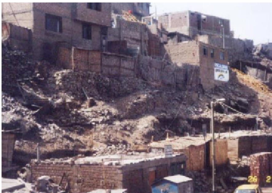
Figura 3.25: Cimentación con muro de piedra tipo pirca A. H. 3 de Mayo, Distrito de San Martín de Porres.
