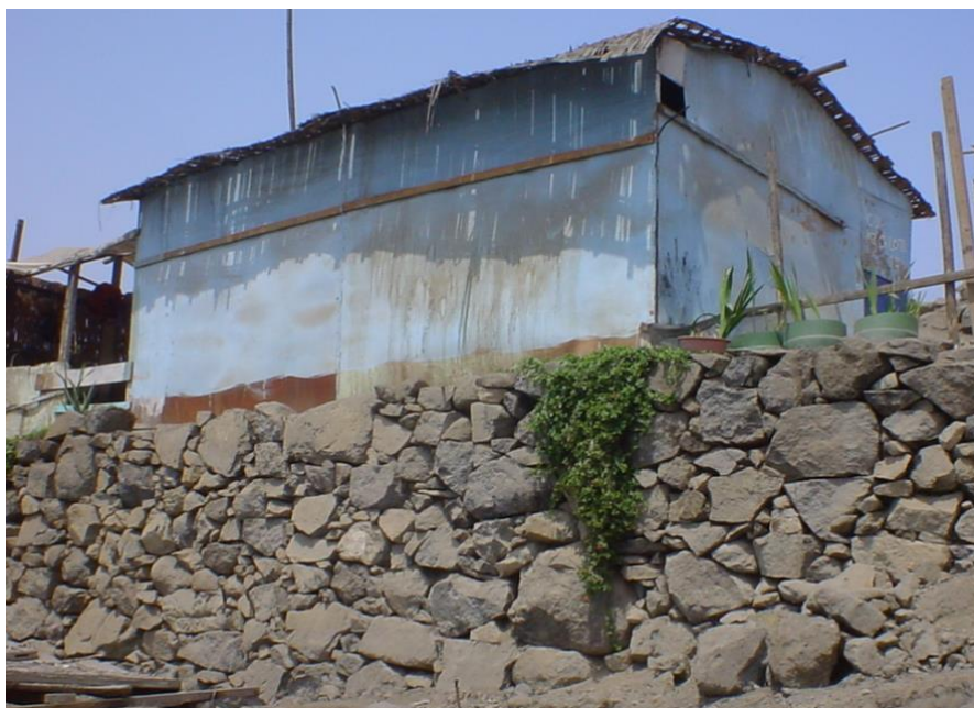
Figura 3.11: Cimentación con muro de piedra tipo pirca A. H. 19 de Abril, Distrito de San Juan de Lurigancho.
