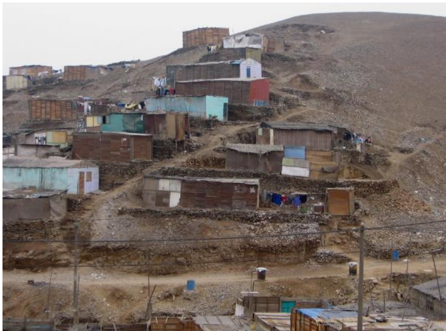
Figura 3.28: Cimentación con muro de piedra tipo pirca A. H. Kenyi Fujimori, Distrito de Ventanilla.
