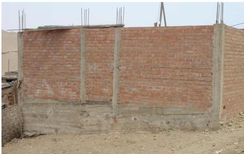
Figura 3.1: A. H. El Golfo de Ventanilla, Distrito de Ventanilla.
