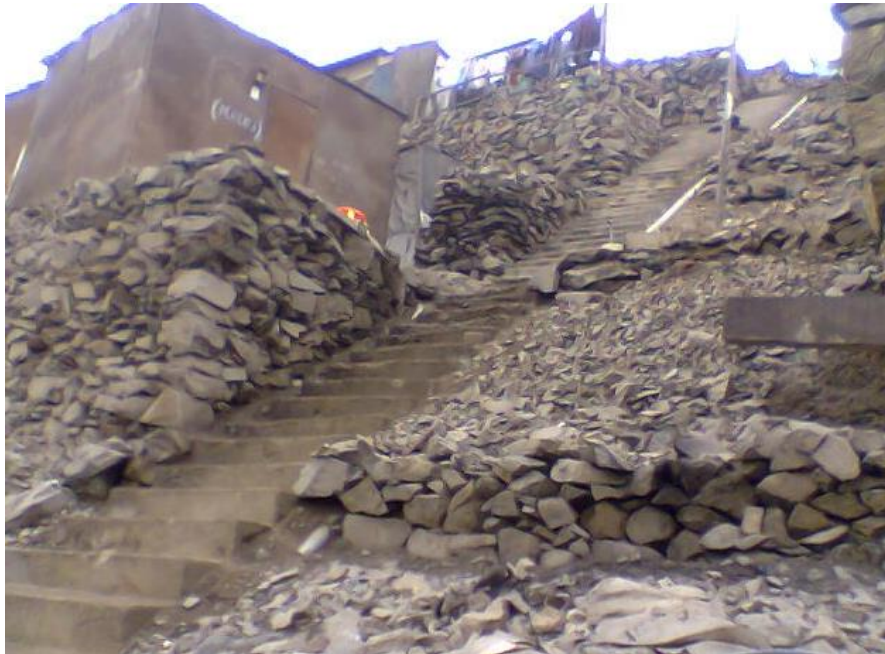
Figura 3.23: Cimentación con muro de piedra tipo pirca A. H. Andrés Avelino Cáceres, Distrito de San Juan de Lurigancho.
