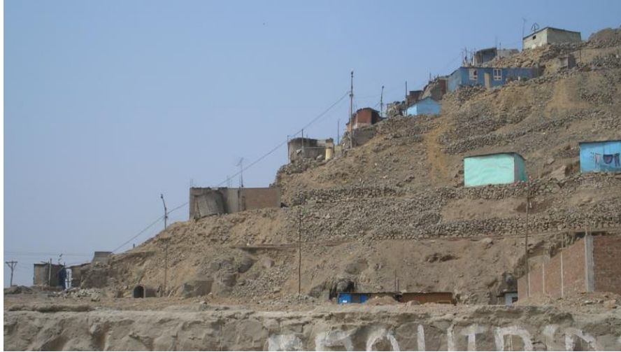
Figura 3.19: Cimentación con muro de piedra tipo pirca A. H. Las Terrazas, Distrito de San Juan de Lurigancho.
