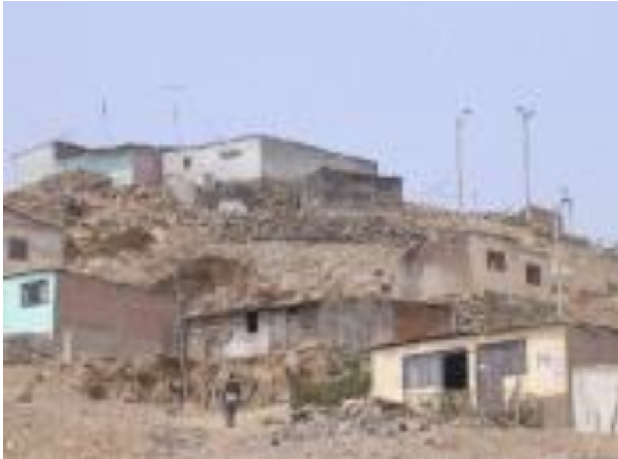
Figura 3.33: Cimentación con muro de piedra tipo pirca A. H. Villa Los Reyes, Distrito de Ventanilla.
